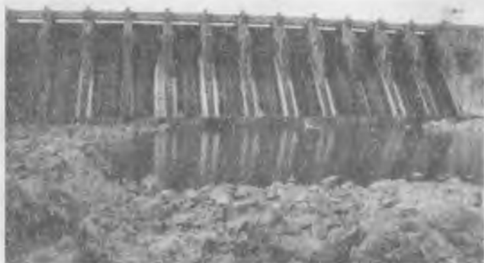
4-rasm. Miathon platinasi ko'rsatilgan. Platinaning uzunligi 4789m, balandligi 50m. Bu platina maxsus sel va boshqa kuchli yog'ingarchiliklarni oldini olish, Shuning bilan birga 60 000 kVt energiya beradigan stansiyanı yuritish uchun qurilgan.
