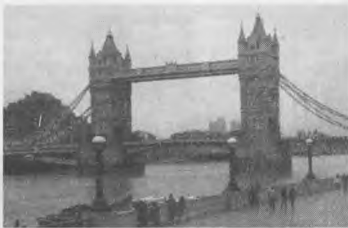
3-rasm. 1886- va 1894- yillarda qurib tugutilgan osma ko'prik. Ko'prikni bog'lovchi vosita beton va po'lat qotishmali tross. Ko'prikning uzunligi 244m. Qo'yilgan moslamalar qum, tuproq va tog' jinslarini oqimi hamda tabiiy ofatlarni oldini olishda asosiy rol o'ynaydi.
