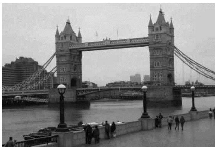
3-rasm. 1886 va 1894 yillarda qurib tugatilgan osma ko‘prik. Ko‘prikni bog‘lovchi vosita beton va po‘latli qotishmali tross. Ko‘prikning uzunligi 244m. Qo‘yilgan moslamalar qum, tuproq va tog‘ jinslarini oqimi hamda tabiiy ofatlarni oldini olishda asosiy rol o‘ynaydi
