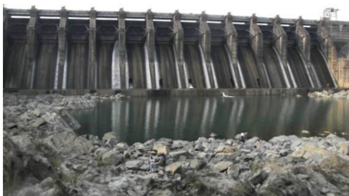
4-rasm. Miathon platinasi ko‘rsatilgan. Platinani uzunligi 4789m, balandligi 50m. Bu platina maxsus sel va boshqa kuchli yog‘ingarchiliklarni oldini olish, shuning bilan birga 60 000 kVt energiya beradigan stansiyaning yuritish uchun qurilgan
