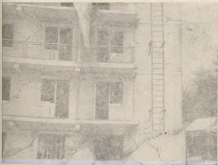
26-расм. Душанбеда пролювиал лёсс устига қурилган бино пойдеворининг суънинг таъсирида чўкишидан бинонинг бузилиши.
