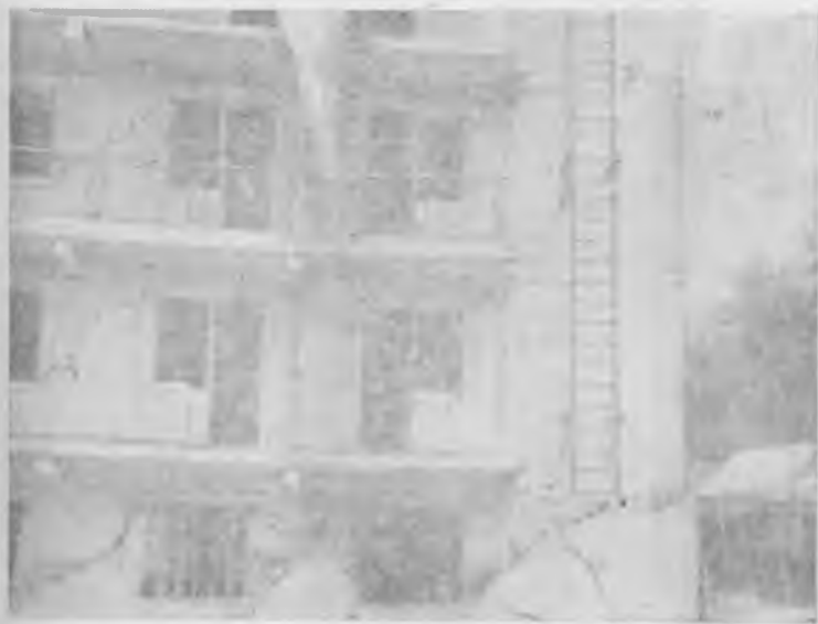
26-расм. Душанбеда пролювиал лёсс устига қурилган бино пойдеворининг суянинг таъсирида чўкишидан бинонинг бузилиши.
