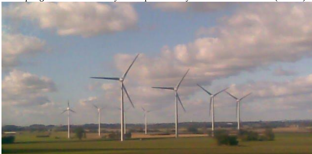
1-rasm. SHamol generator qurilmasi va elektrostansiyasi .
