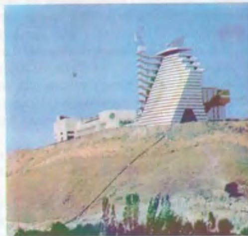
Общий вид гелиокомплекса с подъездной дороги.
