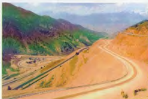
Строительство новой дороги на перевале "Камчик"
