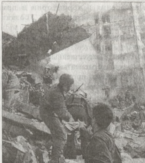
Рис. 14 Разрушение жилого дома в результате взрыва, вызванного аварией в системе газоснабжения.
