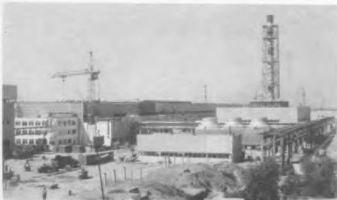
Строительство автомобильного завода "УзДЭУ". в г. Асака
