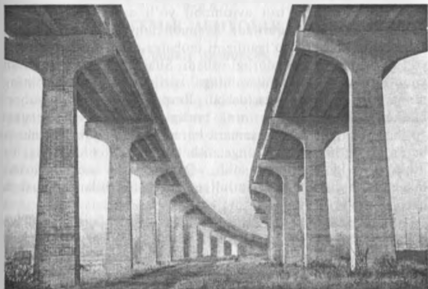
Temirbeton konstruksiyali avtomobil ko'prigi.
