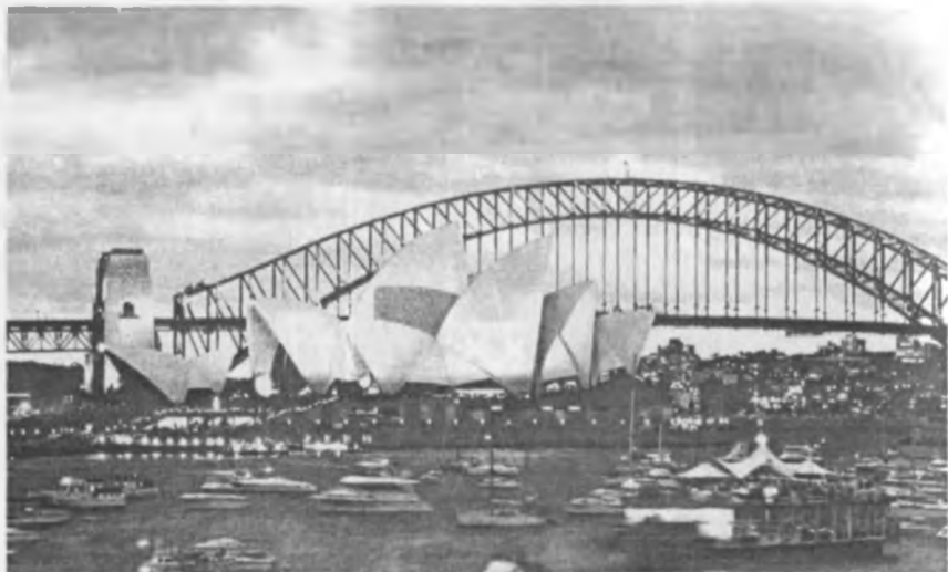
Arkali temir konstruksiyadan ishlangan ko'prik.
