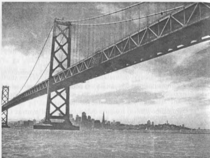
Temir konstruksiyali ko'prik.
