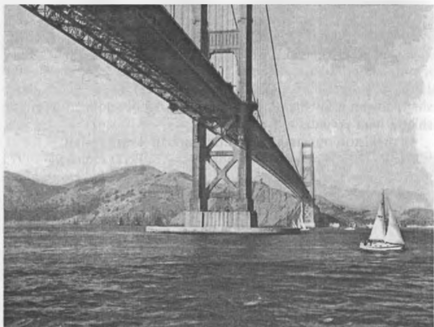
Asfalt-beton bilan qoplangan temir konstruksiyali osma ko'pri.
