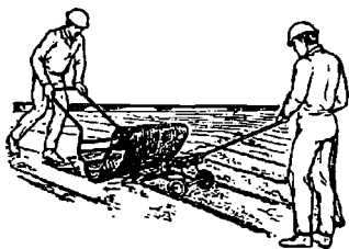
10.1-rasm. Eritiladigan ruberoid asosida tomoni gidroizolatsiyalash.
