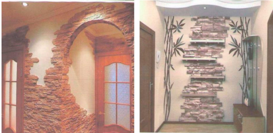
17.6-rasm. Xona devori (a) va eshiklar atrofini (b) tabiiy toshlar bilan pardoqlash
