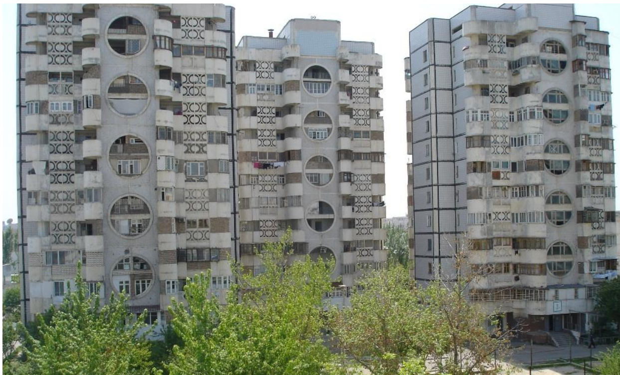
6.5-rasm Betonni yirik panelli binolar qurishda qo'llanilishi (Toshkentdagi Oxunboboev maydonidagi turar-joy binolari).
