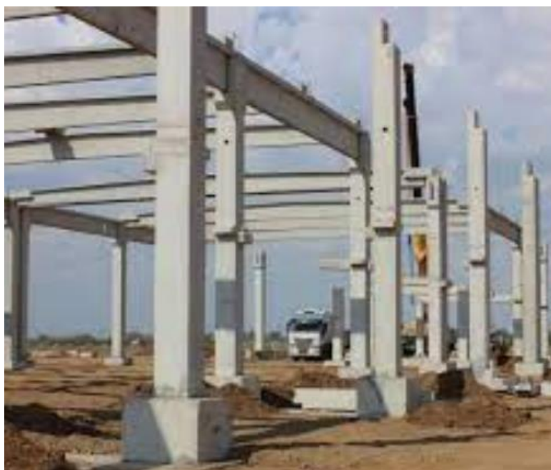
7.4-rasm. Bir va ikki konsolli ustunlar va to‘sinlarning qurilishmaydonida va chizmada ko‘rinishi.
