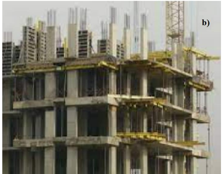
7.8-rasm. a) monolit usulda barpo etilgan osmono'par bino; b) monolit usulda barpo etilayotgan binoning qurilish jarayoni.
