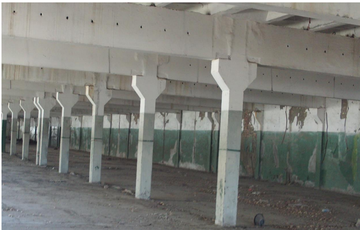
6.3-rasm Betonni sanoat binolarining temirbeton karkaslarini barpo etishda ishlatilishi (Buxoro qorako'l zavodi ishlab chiqarish sexi).
