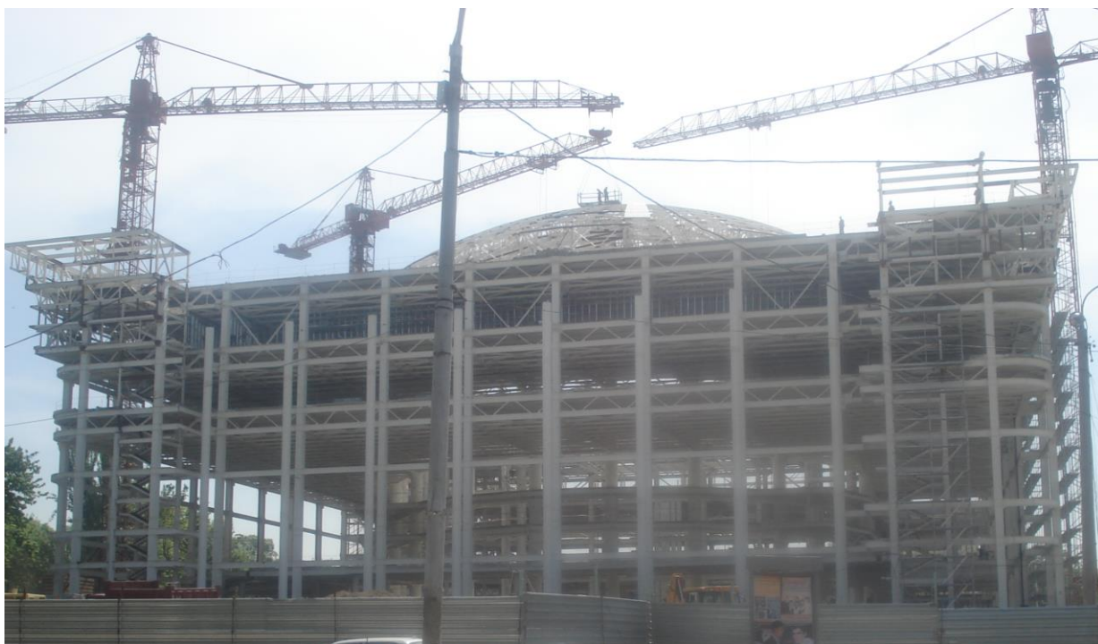
17.1-rasm. Metallni Toshkent shahri “Forumlar zali” binosi karkas elementlarini tiklashda ishlatilishi.
