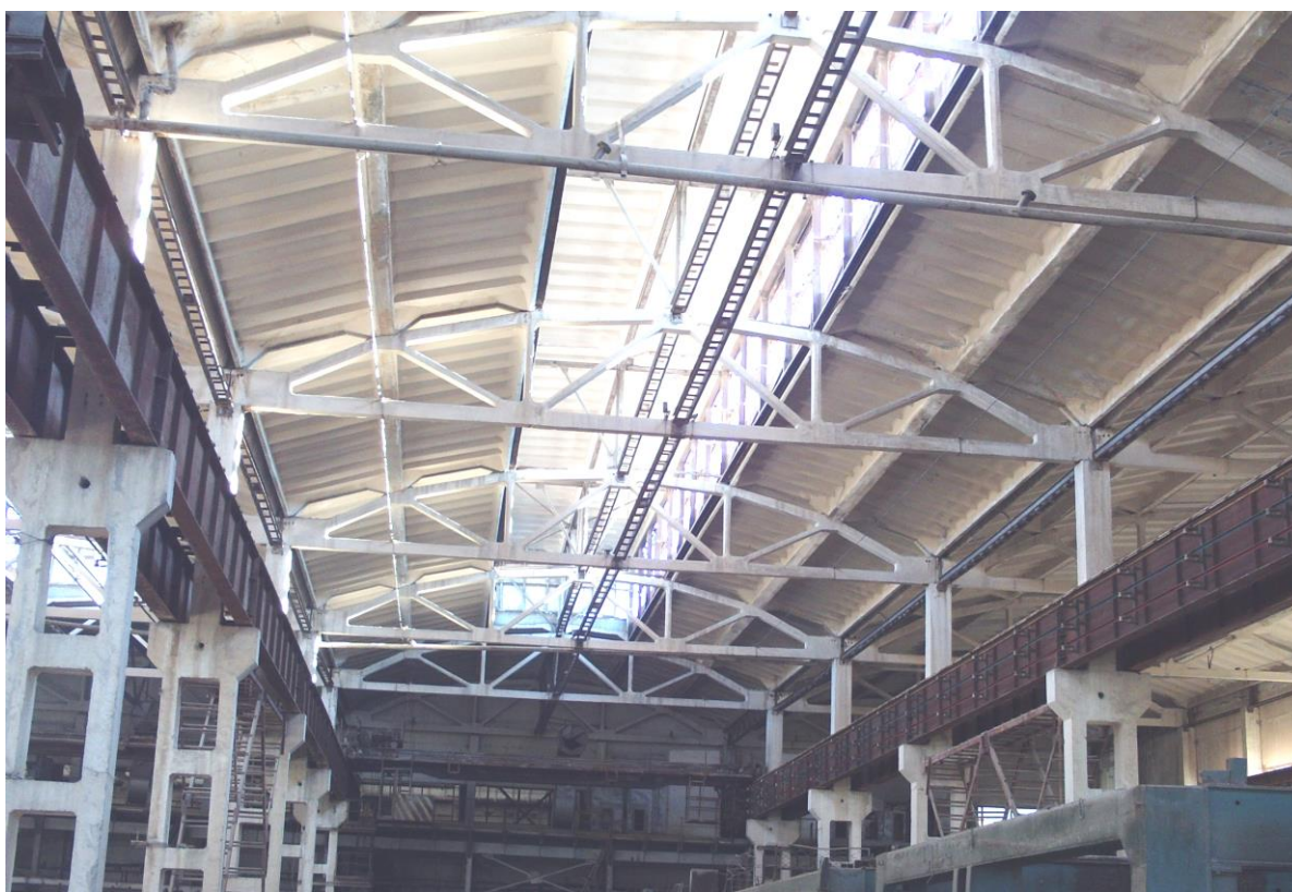
6.2-rasm. Betonni sanoat binolarining temirbeton karkaslarini barpo etishda ishlatilishi (Buxoro uysozlik kombinati ishlab chiqarish sexi).
