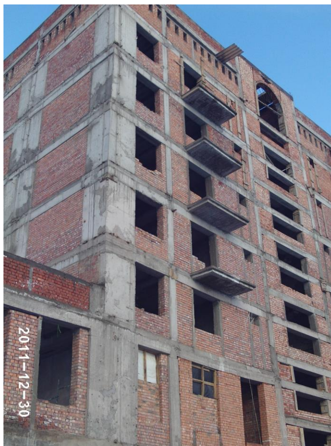
3.9-rasm. 2012 yilda Toshkentda A.Navoiy ko'chasida qurilgan turar-joy binosi devorlarini qurishda keramik g'ishtning ishlatilishi.
