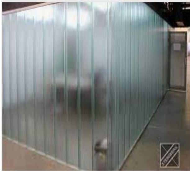
4.10-rasm. Shisha profilit fragmentlari.
