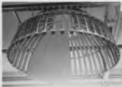
12.17-rasm. Gumbaz metall sinchining umumiy ko'rinishi.
