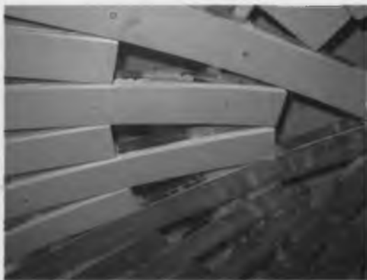
12.20-rasm. Qalinligi 9,5 mm bo'lgan gipskarton tasmalari bilan qisman qoplangan gumbaz sinchining fragmenti.
