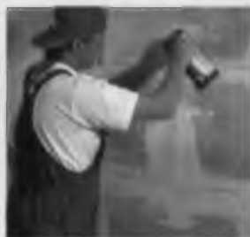
14.13-j rasm. Plitalar orasidagi choklarni silliqlash.
