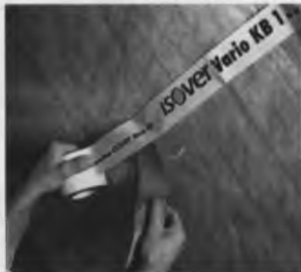
7.7-rasm. Bir-biriga 10 sm kiydirilgan plyonka polotnosini yotqizish va hosil bo'lgan choklarga yopishqoq tasma yelimlash.
