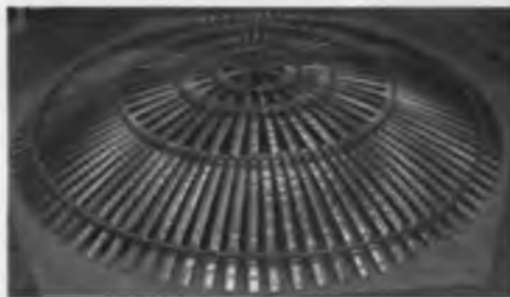
12.17-rasm. Gumbaz metall sinchining umumiy ko'rinishi.
