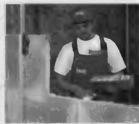
14.13-g rasm. Keyingi qatorlarni terishda pastki qator o'yiqlariga yelim surtish.
