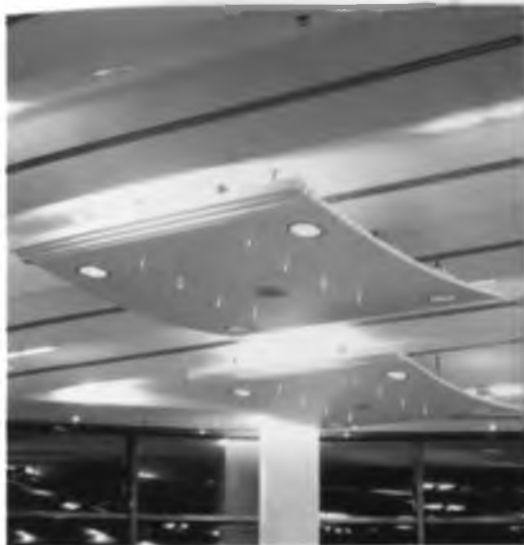
12.15-rasm. Osmo shiftlar yechimida yelkansimon gipskarton elementlar.
