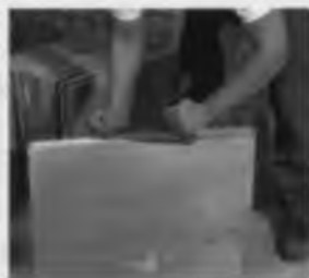
14.13-d rasm. Birinchi qatorning barcha plitalaridagi qirralarni olib tashlash.
