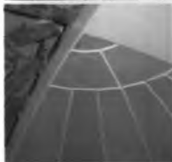
12.22-rasm. GKQ segmentlari bilan qilingan gumbaz qoplamasining umumiy ko'rinishi.
