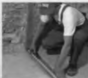
14.13-b rasm. Asosga elastik tovushni izolatsiya qiladigan qistirmanini yelimlash.
