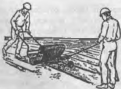
Рис.10.1. Гидроизоляция крыш на основе направляемого рубероида.
