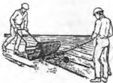
10.1-rasm. Eritiladigan ruberoid asosida tomni gidroizolatsiyalash.
