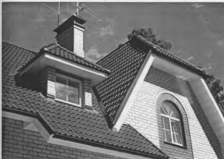
Рис. 2.27. Кровля из металлочерепицы
