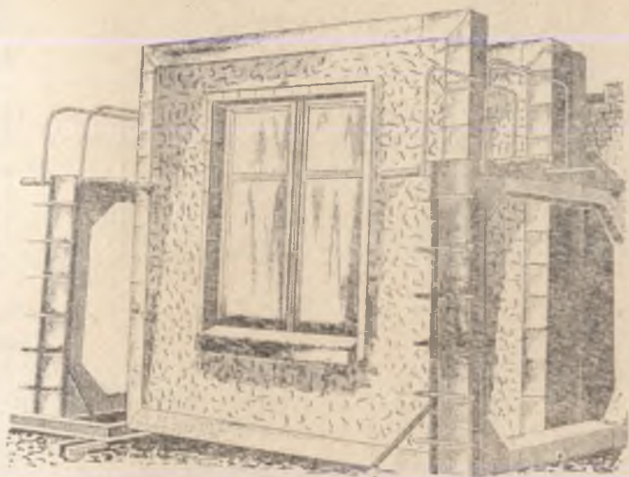
Рис. 99. Склади́рование стеновых панелей в металличе- ских кассетах
