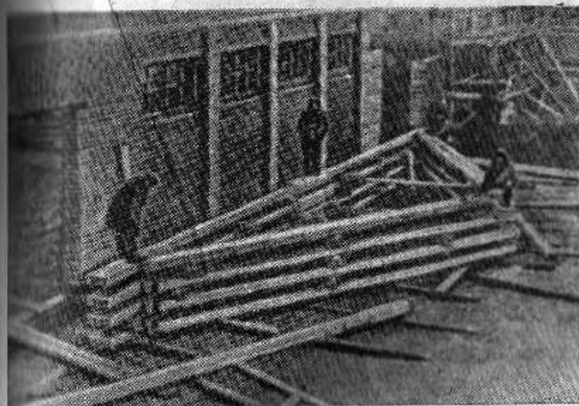
Рис. 28. Сборка треугольных клееных ферм
