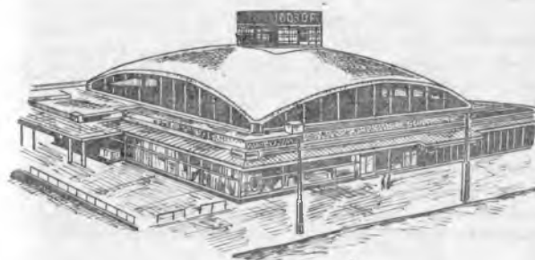
15.20- расм. Қўшалок гаусс мусбат эгрилигига эга бўлган темир-бетон қобикдан тайёрланган еппа
