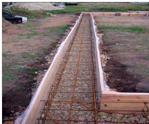
6.12-rasm. Qumli asos (a), shag'alli asos (b) bo'yicha armaturalash ishlari bajarilgan
