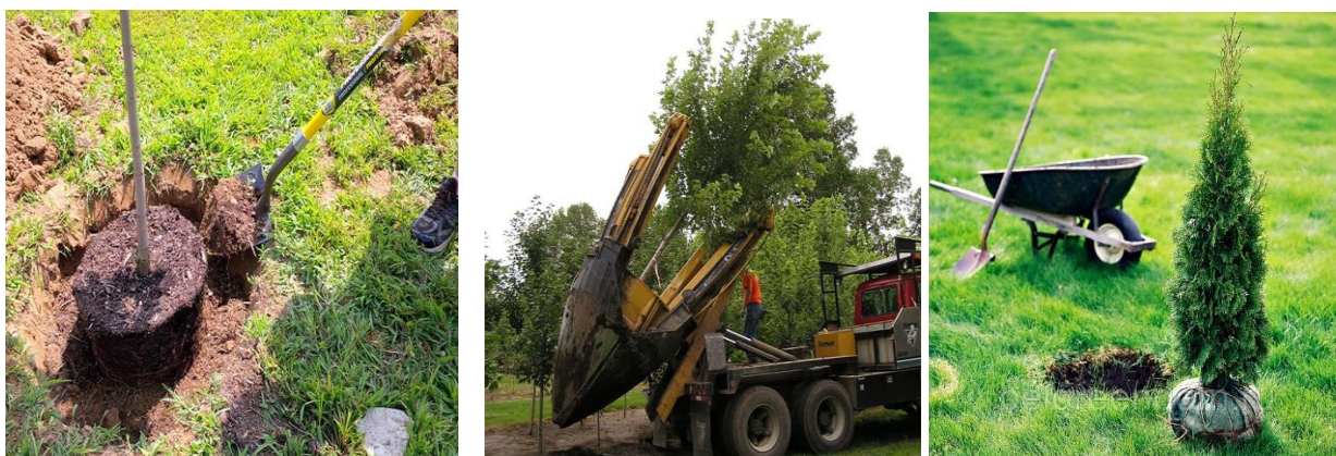
2.14- rasm. Qurilish maydonidan o'sib turgan qimmat daraxtlarni ko'chirish
