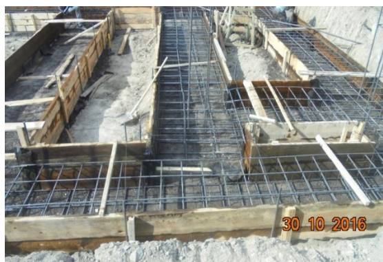
6.13-rasm. Asfaltdangan asos va uning ustidan o'rnatilgan qolip tizimi
