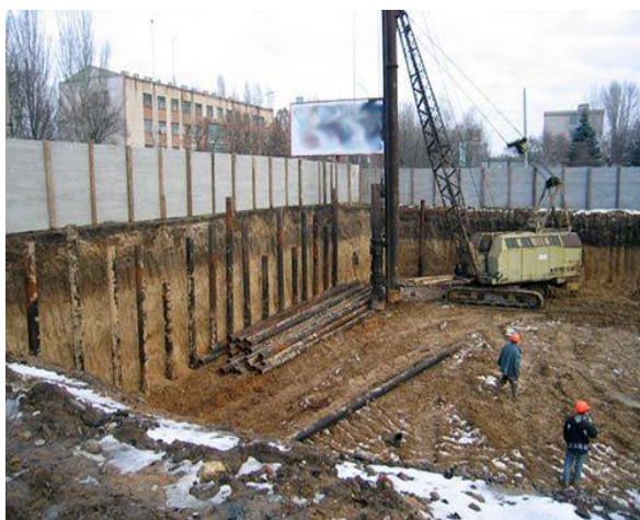
6.23-rasm. Ankerli kuchaytirgichlarda mahkamlangan kotlovan devorlari.
