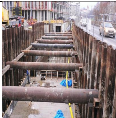
6.19-rasm. Gorizontal tirgakli kuchaytirgichda transheya devorlarini mustahkamlash jarayonidan lavha.
