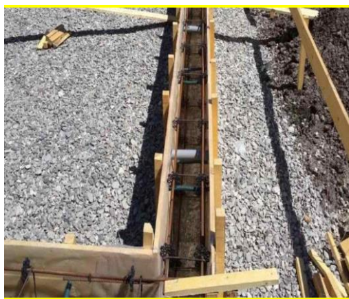
6.12-rasm. Qumli asos (a), shag'alli asos (b) bo'yicha armaturalash ishlari bajarilgan
