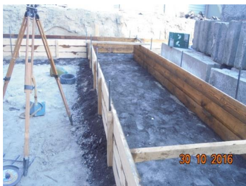
6.13-rasm. Asfaltdangan asos va uning ustidan o'rnatilgan qolip tizimi
