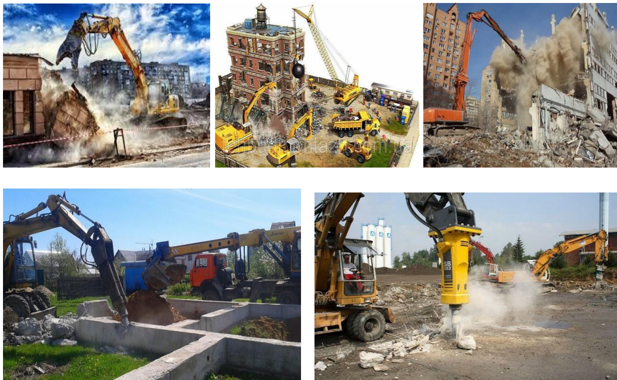
2.16-rasm. Bino va inshootlarni mexanizatsiyalashgan usulda buzish jarayonidan lavhalar
