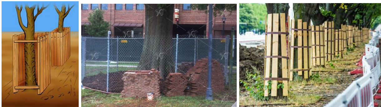
2.13- rasm. Qurilish maydonida daraxtlarni mexanik ta'sirlar, shikastlanishlardan himoyalash
