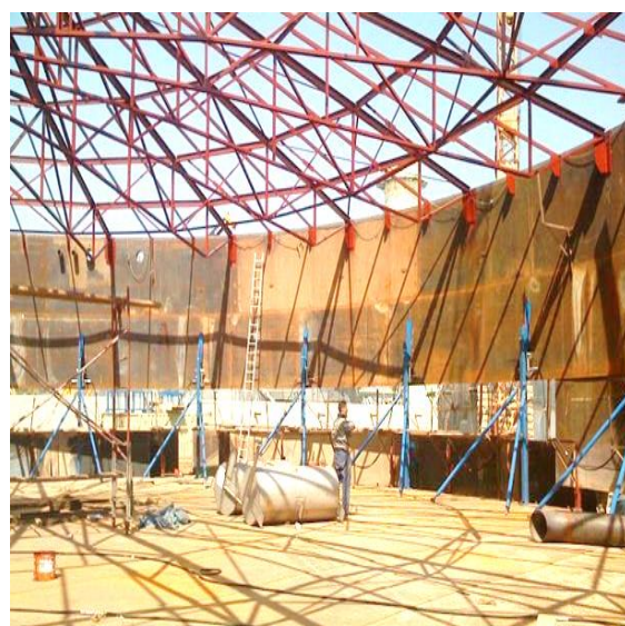
9.6-rasm. Diametri 30 m li og'irligi 300 tonna keladigan rezurvuarni yuk ko'tarish qobiliyati 12 tonnali 30 ta domkratda montaj qilish jarayoni.
