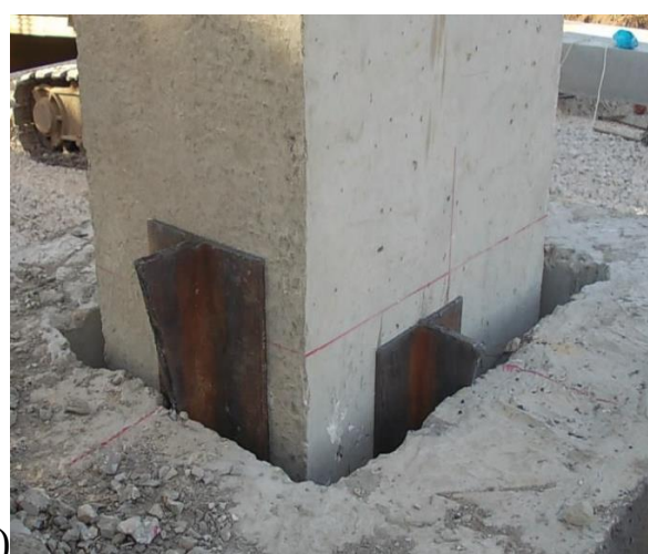
10.8 -rasm. Temirbeton ustunni poydevor stakani ustida qabul qilinish jarayoni (a). Loyihaviy holati ta'minlangan temirbeton ustunni metall fonalar (klinya) bilan vaqtinchalik mahkamlash (b).
