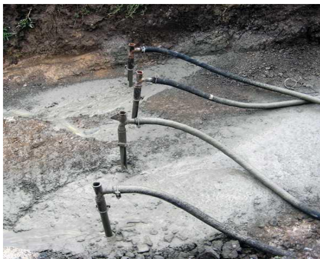
4.10-rasm. Grunt asosni sementlash jarayonidan lavha. Burg'ulash texnikasi.
