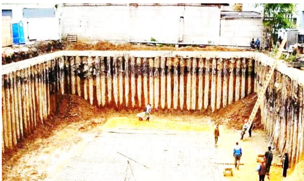
6.16-rasm. Shpuntli mustahkamlagichda mustahkamlangan kotlovan devorlari
