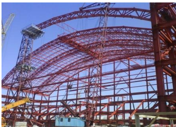
9.1- rasm. Yirik qamrovli (proletli) bino va inshootlar: a-foydalanishga tayyor sport arenasi; b, v, g-sportarenasining qurish jarayonidan lavhalar.
