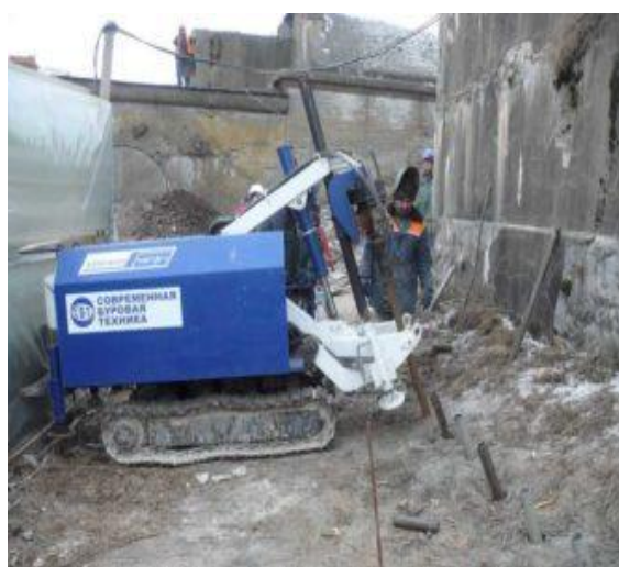
4.10-rasm. Grunt asosni sementlash jarayonidan lavha. Burg'ulash texnikasi.
