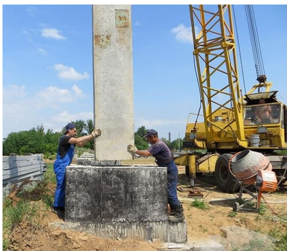
10.8 -rasm. Temirbeton ustunni poydevor stakani ustida qabul qilinish jarayoni (a). Loyihaviy holati ta'minlangan temirbeton ustunni metall fonalar (klinya) bilan vaqtinchalik mahkamlash (b).
