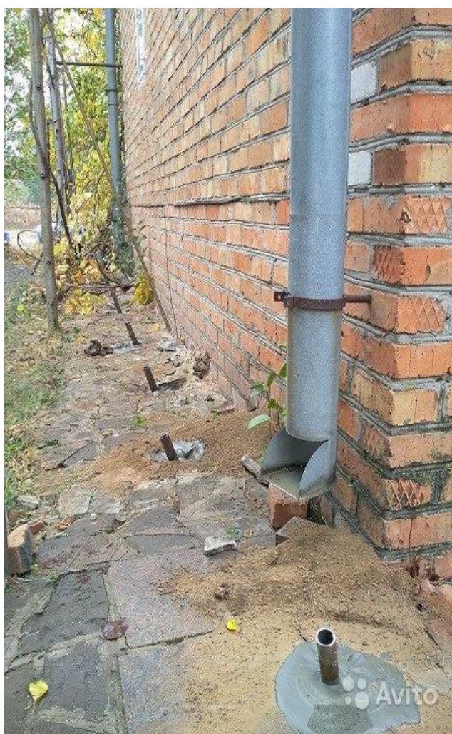
4.14-rasm. Binolar grunt zaminini sementlash jarayonidan lavhalar: a-poydevori cho'kkan bino grunt zaminini sementlash jarayoni; b- erto'la poli ostidagi grunt zaminini sementlash jarayoni; v- grunt zamini sementlash bilan mustahkamlanayotgan bino.
