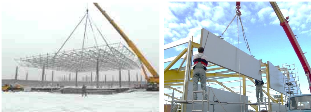
9.8-rasm. Kranning bino tashqarisida turib konstruktiv elementlarni montaj qilish jarayoni: a-tom elementlari montaji; b-devor panellari montaji.
