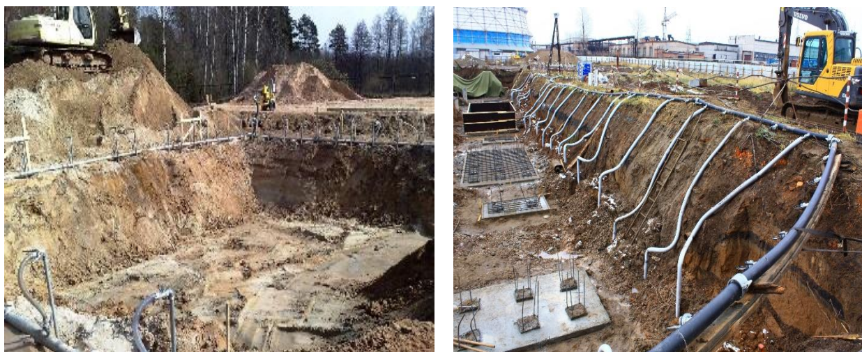
2.22-rasm. Nina filtrli suv tortish qurilmalari yordamida erosti suvi sathini pasaytirish jarayonidan lavhalar
