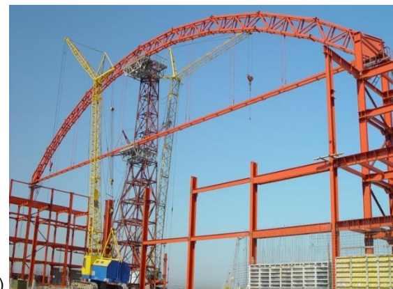
9.1- rasm. Yirik qamrovli (proletli) bino va inshootlar: a-foydalanishga tayyor sport arenasi; b, v, g-sportarenasining qurish jarayonidan lavhalar.
