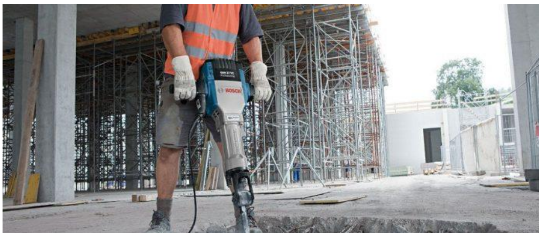
2.17-rasm. Bino va inshootlar, ularning konstruktiv elementlarini yarim mexanizatsiyalashgan usulda buzib olish
