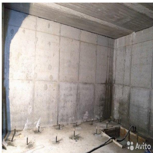
4.14-rasm. Binolar grunt zaminini sementlash jarayonidan lavhalar: a-poydevori cho'kkan bino grunt zaminini sementlash jarayoni; b- erto'la poli ostidagi grunt zaminini sementlash jarayoni; v- grunt zamini sementlash bilan mustahkamlanayotgan bino.
