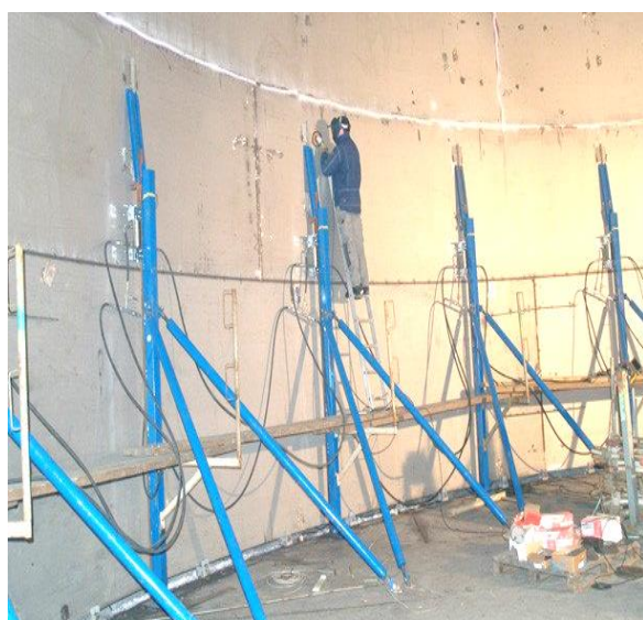
9.6-rasm. Diametri 30 m li og'irligi 300 tonna keladigan rezurvuarni yuk ko'tarish qobiliyati 12 tonnali 30 ta domkratda montaj qilish jarayoni.
