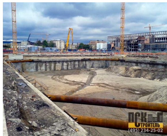
6.23-rasm. Ankerli kuchaytirgichlarda mahkamlangan kotlovan devorlari.
