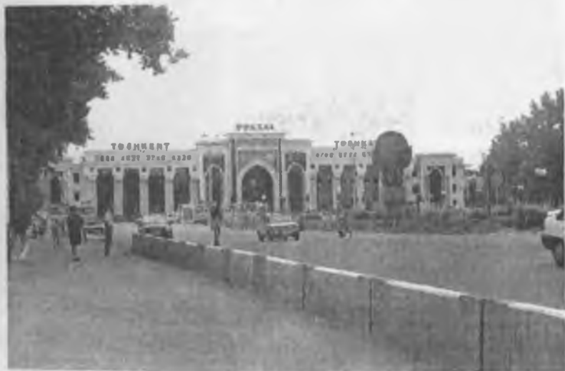
1.12-rasm. Shimoliy temir yo'l vokzali binosi
