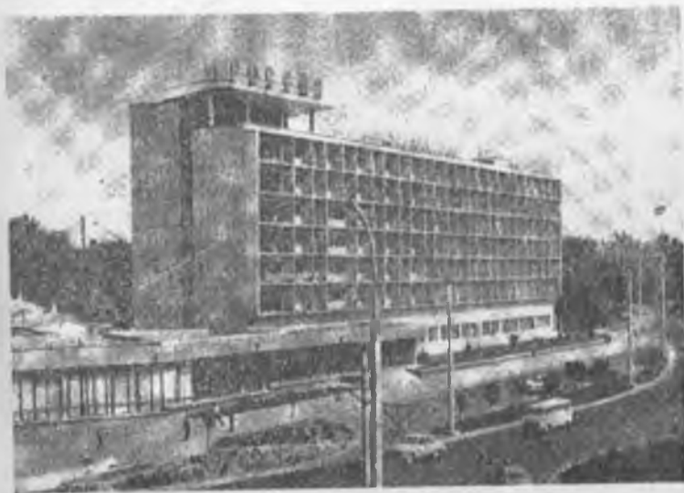
1.8a-rasm. Rossiya mehmonxonasi (rekonstruksiyaga qadar)
