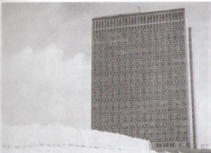
1.5a-rasm. Ma'muriy bino (rekonstruksiyaga qadar).
