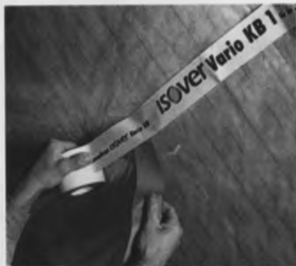
7.7-rasm. Bir-biriga 10 sm kiydirilgan plyonka polotnosini yotqizish va hosil bo'lgan choklarga yopishoq tasma yelimlash.
