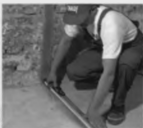
14.13-b rasm. Asosga elastik tovushni izolatsiya qiladigan qistirmani yelimlash.
