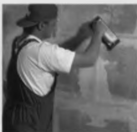
14.13-j rasm. Plitalar orasidagi choklarni silliqlash.
