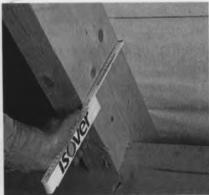
7.5-rasm. Tom stropila oyoqlari balandligi bo'yicha isitkichning qalinligini aniqlash.
