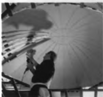
12.21-rasm. GKQ dan qilingan segmentlar yordamida gumbaz sinchini qoplash sxemasi.
