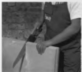
14.13-e rasm. Yig'ma elementlar O'TP ni arralash yo'li bilan tayyorlash.
