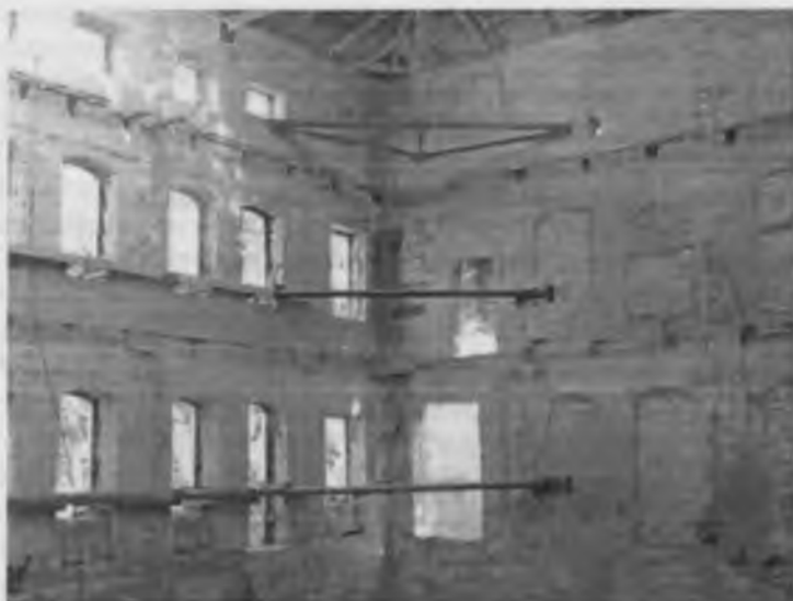
Рис. 9.10. Укрепление капитальных стен временным креплением при реконструкции зданий.
