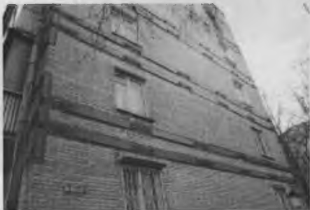
Рис. 8.15. Усиление кирпичной кладки.
