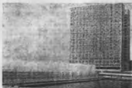
Рис .16а. Административное здание (до реконструкции).
