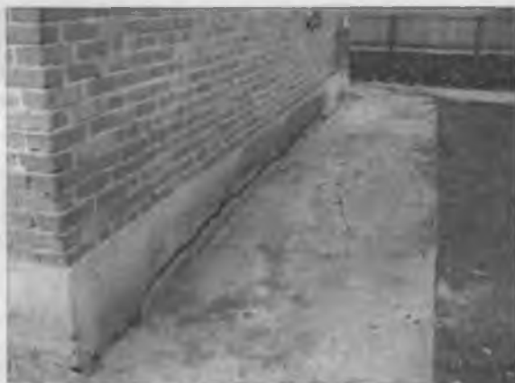
Рис. 8.7. Проседание отмостки вокруг жилого дома вследствие неудовлетворительного уплотнения и замачивания грунтов основания.
