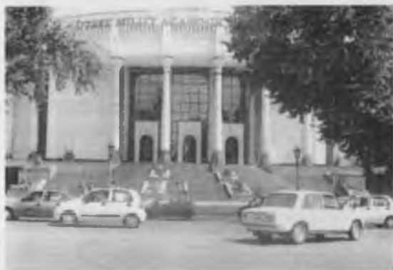
Рис. 1.176. Узбекский национальный академический театр (после реконструкции).
