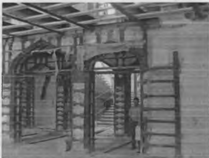
Рис. 9.11. Усиление кирпичных стен старого здания стальными обоями, установка нового перекрытия по стальным балкам.
