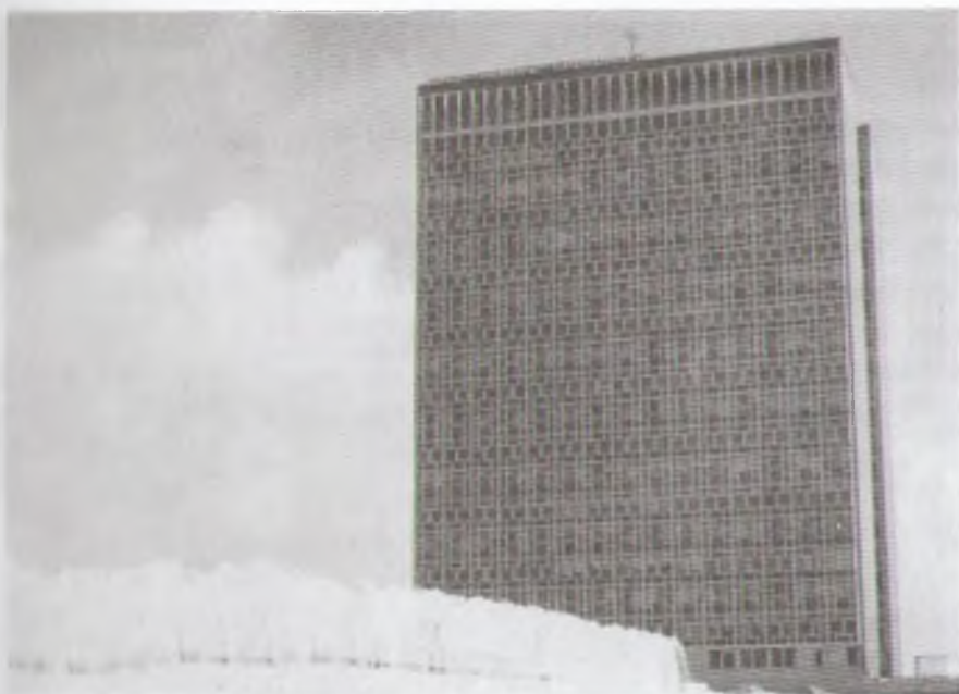
1.5a-rasm. Ma'muriy bino (rekonstruksiyaga qadar).
