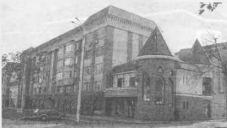
6.5-rasm Toshkent shahridagi 1-qavati magazinlardan iborat bo'lgan 5 qavatli zamonaviy turar-joy binosi
