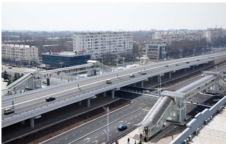
2.43 –расм. Тошкент шаҳар Новза метроси ёнидаги темирбетон йўл ўтказгич
