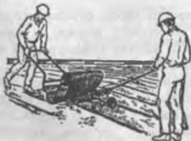
Рис.10.1. Гидроизоляция крыш на основе направляемого рубероида.
