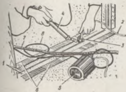
82- расм. Эшик ўрнида икки линолеум гиламини пайвандлаш:
