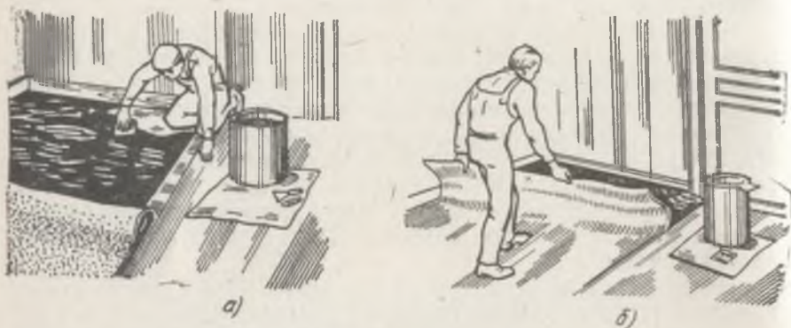
75- расм. Линолеум полотносини ўртасидан букиш методи билан ёпиштириш: а — асосга шпатель билан мастика суркаш; б — линолеум полотносини мастикага ёпиштириш
