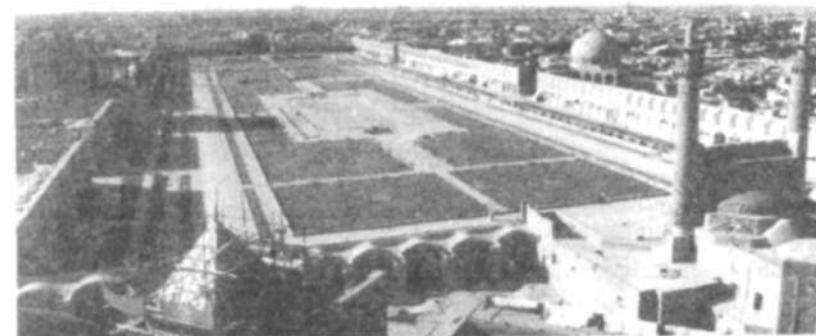
86-rasm. Maydoni Shohning ko'rinishi. Dominanta rolidagi muntazam rejali «chorbog'» va Shoh masjidi.
