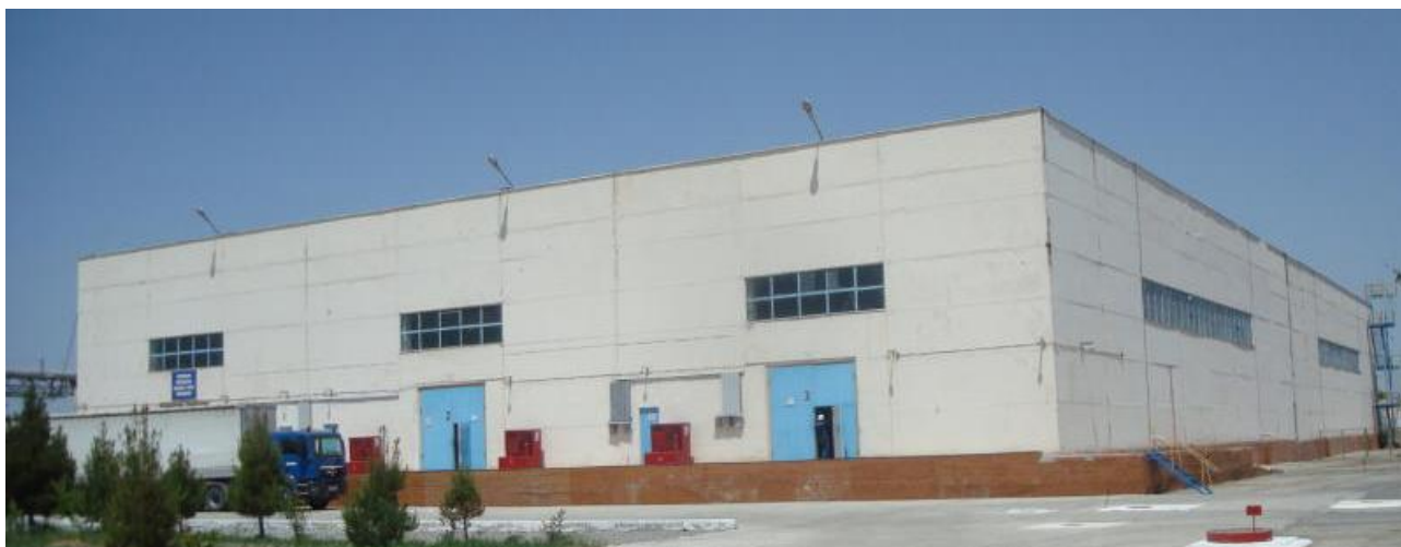
10.7-rasm. Devorlari yirik temirbeton panellardan tayyorlangan 1997 yilda qurilgan “BNPZ” korxonasi sanoat binosining umumiy ko‘rinishi
