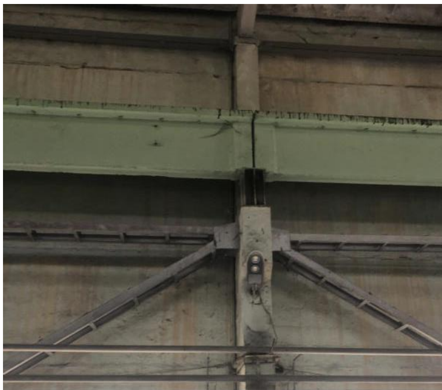
8.17-rasm. Toshkent lokomotiv deposti ta'mirlash sexi binosining bir tuguni (2019 yil); rasm sexni mukammal ta'mirlash oldidan olingan bo'lib, unda chetki qator ustunlariga mahkamlangan bog'lama, ko'prik kran osti to'sini aks etgan
