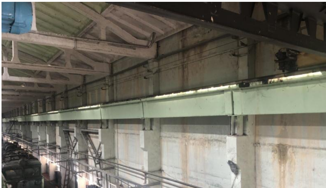
8.16-rasm. Toshkent lokomotiv deposti ta'mirlash sexi binosining bir bo'lagi (2019 yil); rasm sexni mukammal ta'mirlash oldidan olingan bo'lib, unda chetki qator ustunlari, ko'prik kran osti to'sinlari, fermalar, qovurg'ali tom yopmpa plitalari va devor panellari aks etgan
