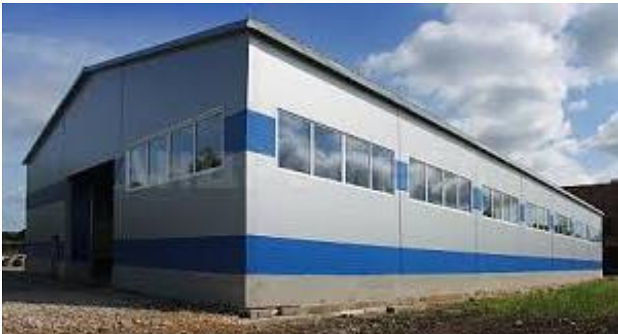
1.9-rasm. Ombor xo‘jalik binosining umumiy ko‘rinishi
