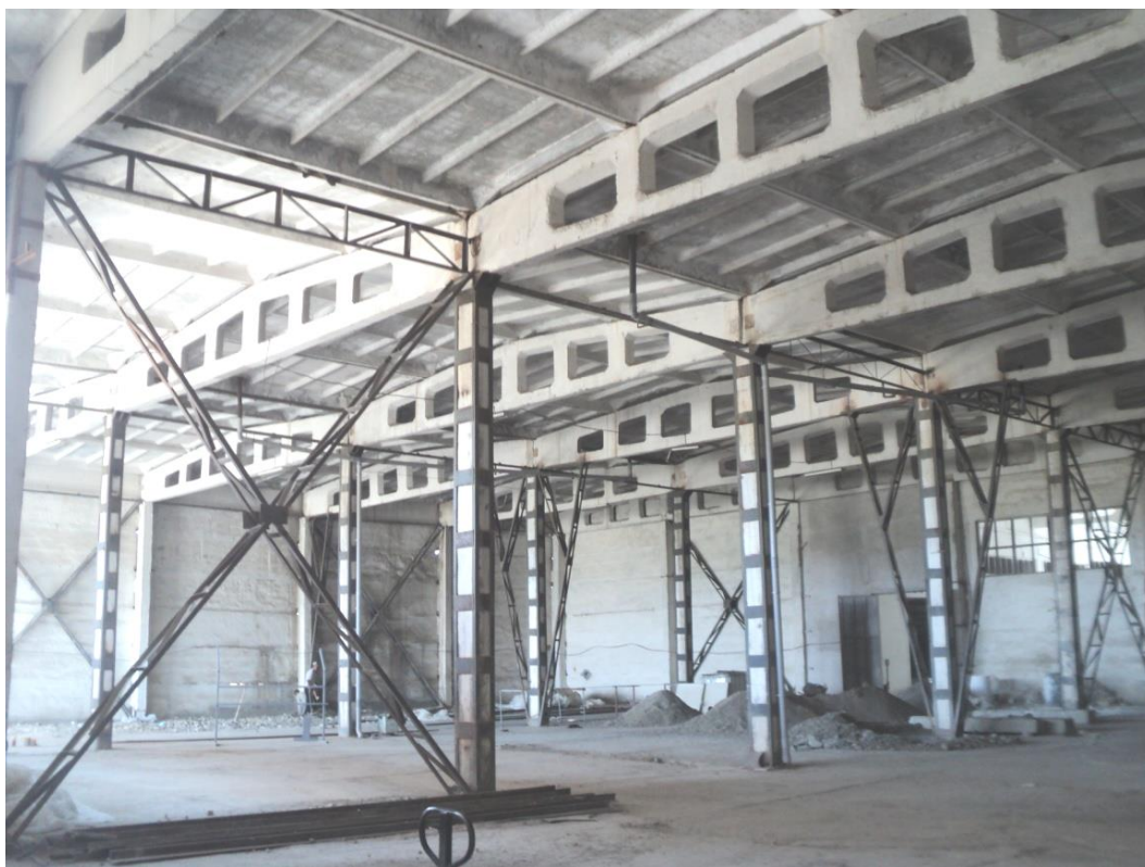
8.41-rasm. Buxorodagi marmar zavodi sanoat binosining bikrligini ta'minlash uchun rekonstruksiya davrida ustunlar bo'ylab o'rnatilgan xoch ko'rinishidagi, to'sinlarga tik yo'nalishda o'rnatilgan ferma shaklidagi metall bog'lamalarning umumiy (2015 yil)
