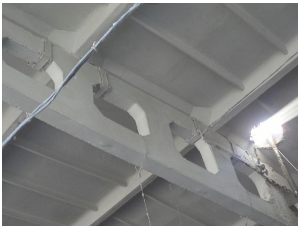
8.22-rasm. Buxoro shahridagi sanoat binolaridan birining bir bo‘lagi; rasmda bir qavatli sanoat binosi temirbeton karkasining ikki nishabli kovakli to‘sinini va qovurg‘ali tom yopma plitalari aks etgan (2020 yil)
