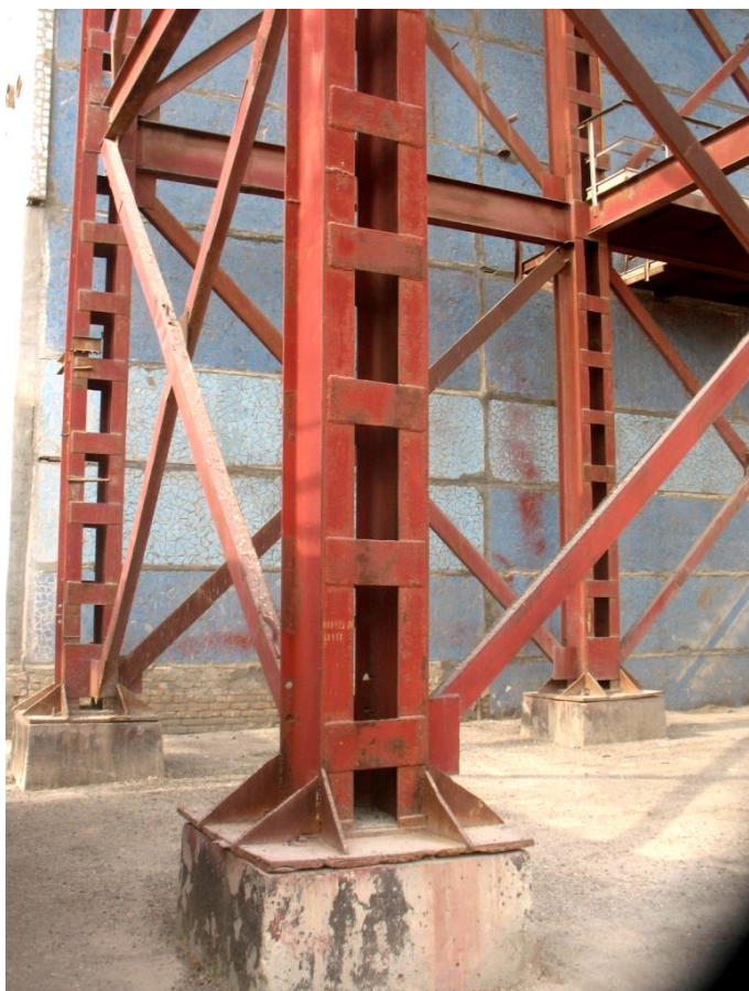
9.8-rasm. “Buxoroenegomarkaz” korxonasida metall konstruksiyalardan tiklangan inshootning temirbeton poydevori va metalli ustunlar boshmoqlarining umumiy ko‘rinishi
