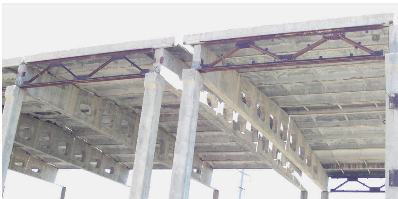
8.41-rasm. Buxorodagi marmar zavodi sanoat binosining bikrligini ta'minlash uchun rekonstruksiya davrida ustunlar bo'ylab o'rnatilgan xoch ko'rinishidagi, to'sinlarga tik yo'nalishda o'rnatilgan ferma shaklidagi metall bog'lamalarning umumiy (2015 yil)
