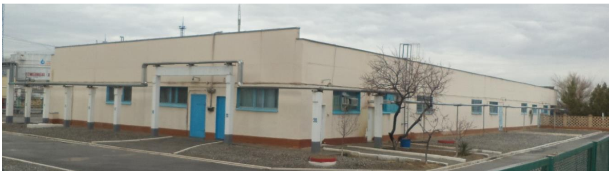
1.7-rasm. Buxoroneftniqayta ishlash zavodi (BNPZ) ning omborxonasi binosining umumiy ko‘rinishi
