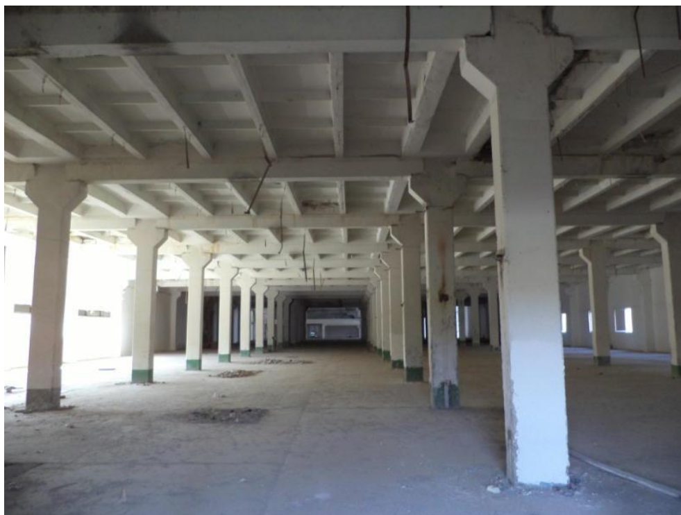
8.6-rasm. Buxorotekstilsotton qo'shma korxonasi binosining rekonstruksiya jarayonidagi ichki ko'rinishi (2019 yil); rasmda rafaqli temirbeton ustunlar, balkalar va g'qovurg'ali tom yopma plitalari aks etgan
