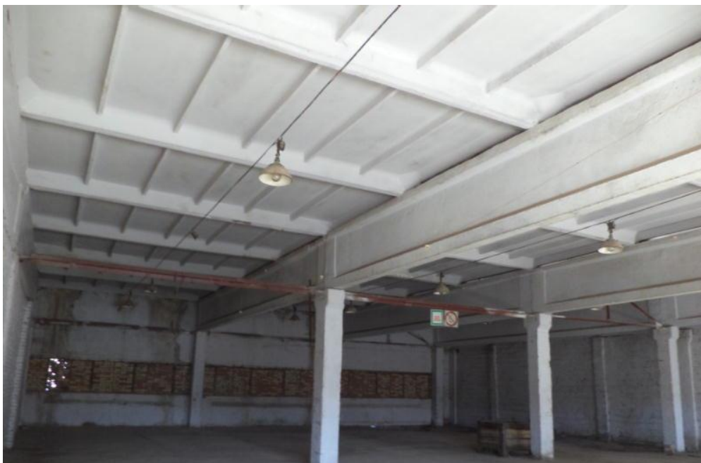
8.48-rasm. Omborxonaning bikrligini ta'minlash uchun ustunlar qadami bo'ylab ularning ustlarida o'rnatilgan metall rasporkalarning umumiy ko'rinishi (2019 yil)
