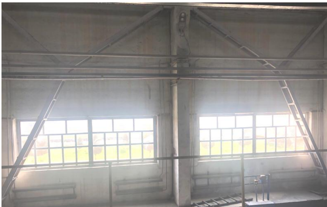
8.37-rasm. “Buxaratekstilsotton” qo‘shma korxonasi sanoat binosining 2-qavat o‘rta qismida ustunlar qatori bo‘ylab o‘rnatilgan poligonal metall bog‘lamaning umumiy ko‘rinishi (2019 yil)
