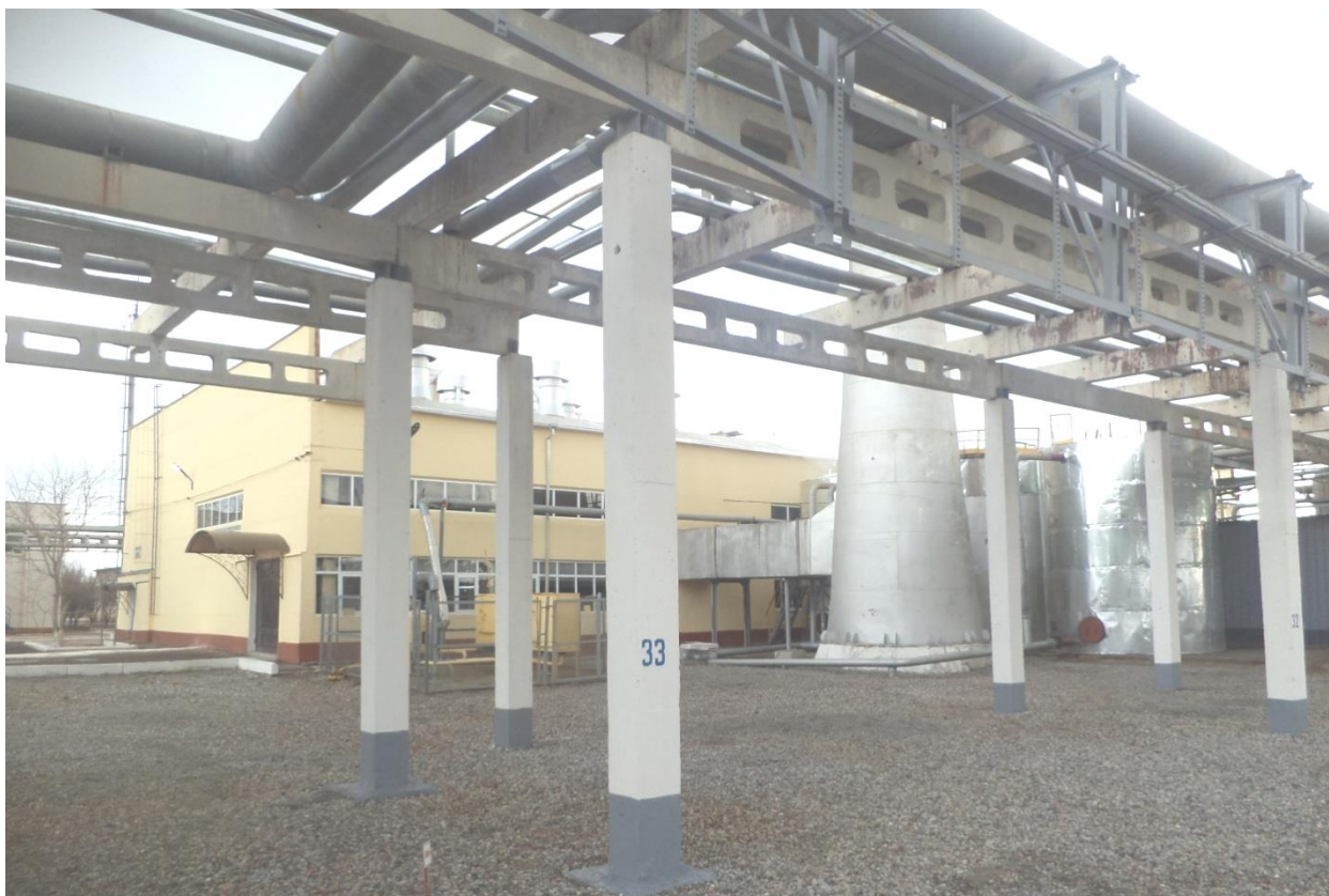
16.12-rasm. Buxoro neftni qayta ishlash zavodi er usti muhandislik tarmoqlarini tutib turuvchi uchun ishlatilayotgan metall va temirbeton konstruksiyalar
