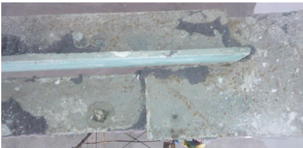
8.52-rasm. Ishlab chiqarish sexi bikrligini ta'minlash uchun ustunlar qadami bo'ylab ularning ustlarida o'rnatilgan metall rasporkaning ustunga mahkamlangan joyining umumiy ko'rinishi (2020 yil)
