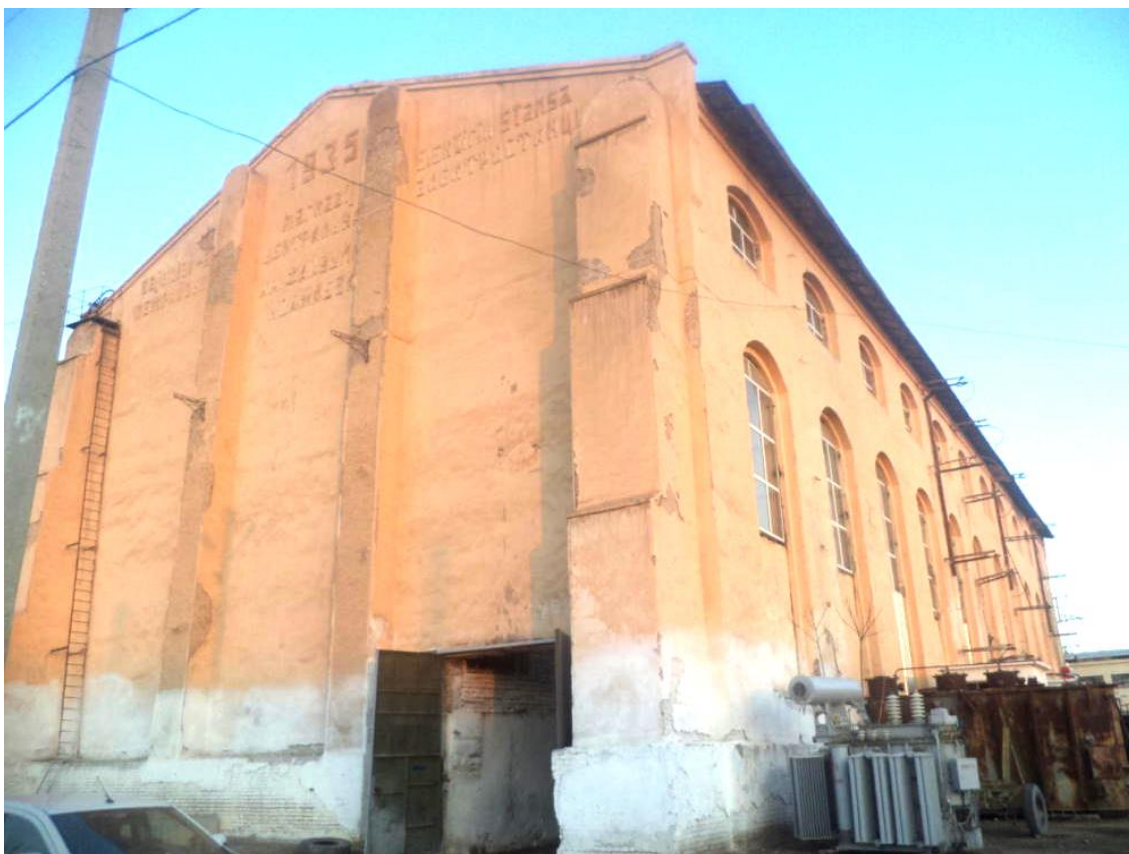
10.3-rasm. 1935 yilda Buxoroda qurib bitkazilgan elektr tarmoqlari korxonasi g'isht devorli tarixiy sanoat binosining umumiy ko'rinishi
