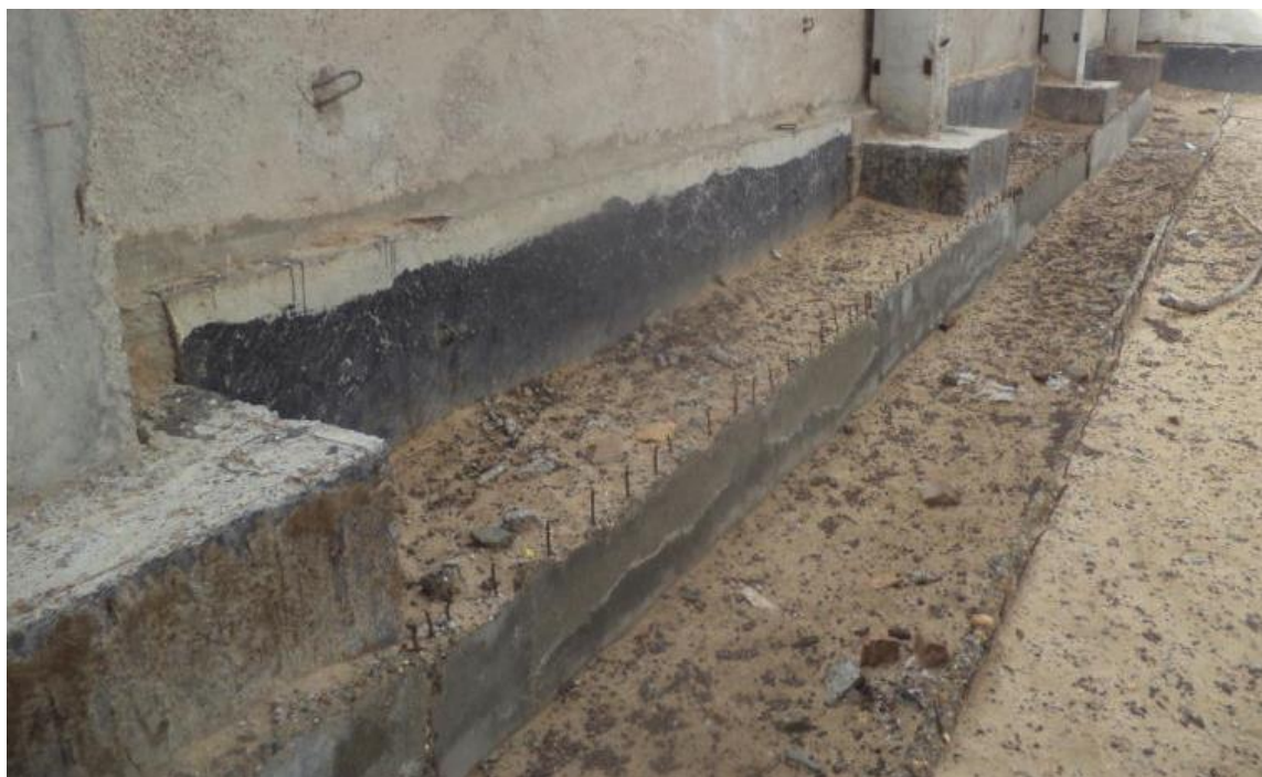
8.12-rasm. Buxoro neftni qayta ishlash zavodi sanoat binolaridan birining temirbeton poydevorlarini umumiy ko‘rinishi (bino zilzilabardoshligini ta’minlash maqsadida ustunli poydevorilar lentali konstruksiyalar bilan birlashtirilgan)
