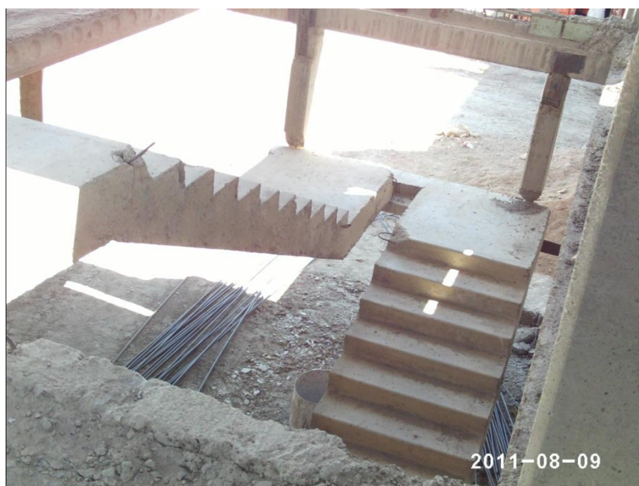
16.9-rasm. “Buxaranaturprodukt” korxonasi binosida bir turdagi temirbetondan tayyorlangan zinapoyaning qo‘llanilishi
