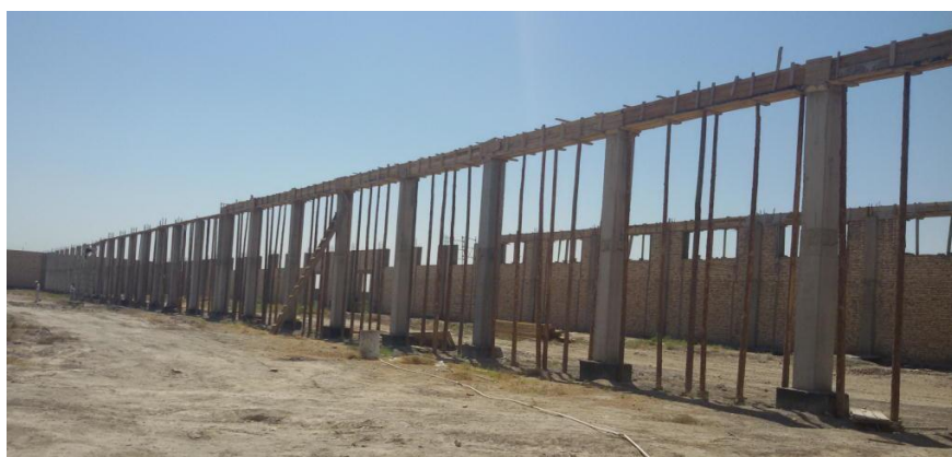
8.3b-rasm. Peshku tekstil fabrikasi poydevorlari va karkas ustunlari va toʻsinlarining qurilish jarayonidagi umumiy koʻrinishi (2019 yil)
