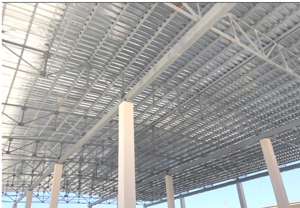
6.29-rasm. Metall konstruksiyalardan tayyorlangan tomning umumiy ko‘rinishi: ustunlar temirbetondan, to‘sinlar qo‘sh shvellerlardan, fermalar burchakliklardan, progonlar ham burchakliklardan, krovli profil to‘shamadan tayerlangan
