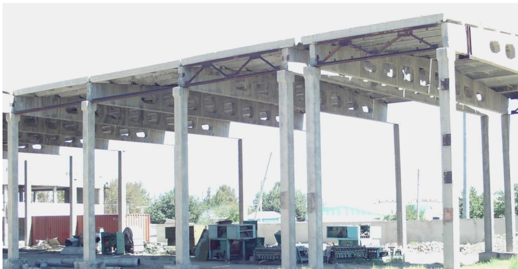
8.2-rasm. Temirbeton karkasli bir qavatli kichkina sanoat binosining umumiy ko‘rinishi
