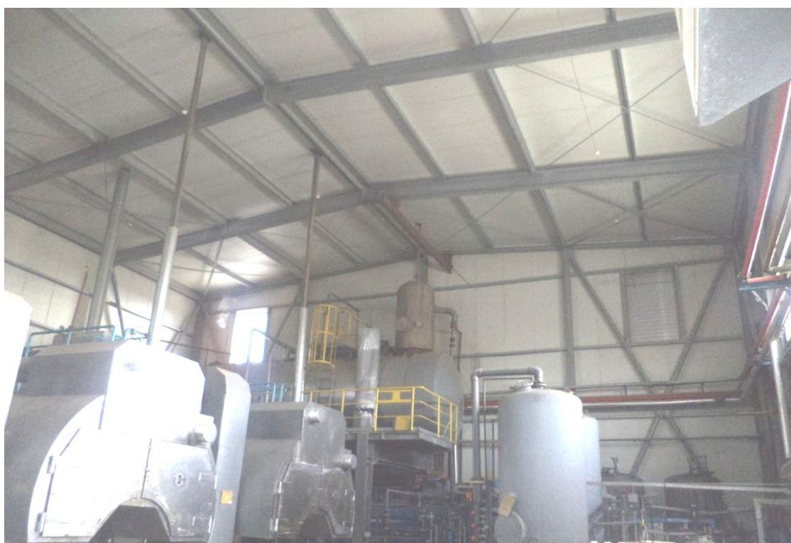
14.2-rasm. Amaliyotda bino to‘siq konstruksiyalarining umumiy ko‘rinishi: 12 m prolyotibo‘lgan yarim rama, xoch bog‘lamalar va sendvich panellar
