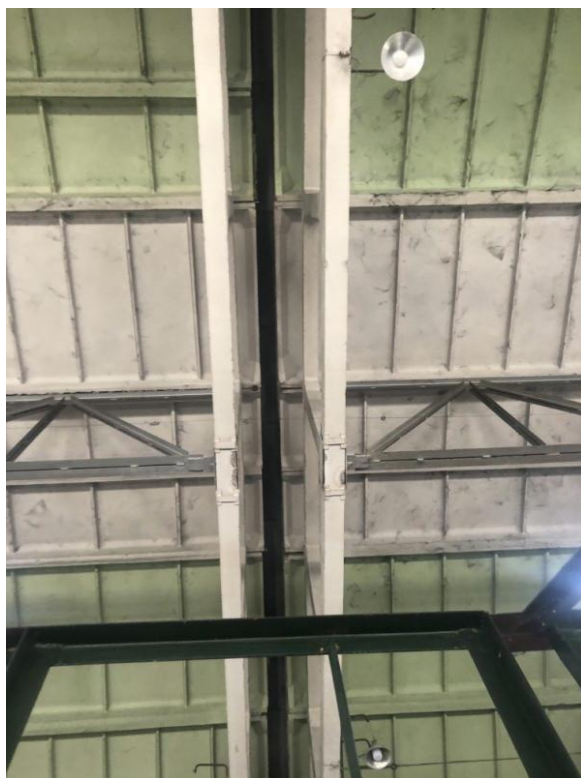
8.47-rasm. Toshkent lokomotiv deposi ta'mirlash sexi binosi tom konstruksiyalarining bir bo'lagi (2019 yil); rasm sexni mukammal ta'mirlashdan avval olingan bo'lib, unda deformatsiya chokidagi tom yopma to'sinlari, ularning bikrligini ta'minlash maqsadida qo'yilgan metall bog'lamalar va qovurg'ali tom yopmpa plitalari aks etgan
