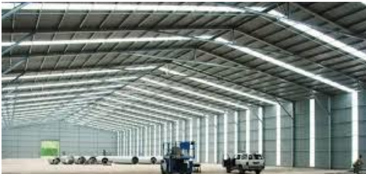
9.3-rasm. Metall konstruksiyalarda ishlangan bir proletli sanoat binosining ichki ko‘rinishi
