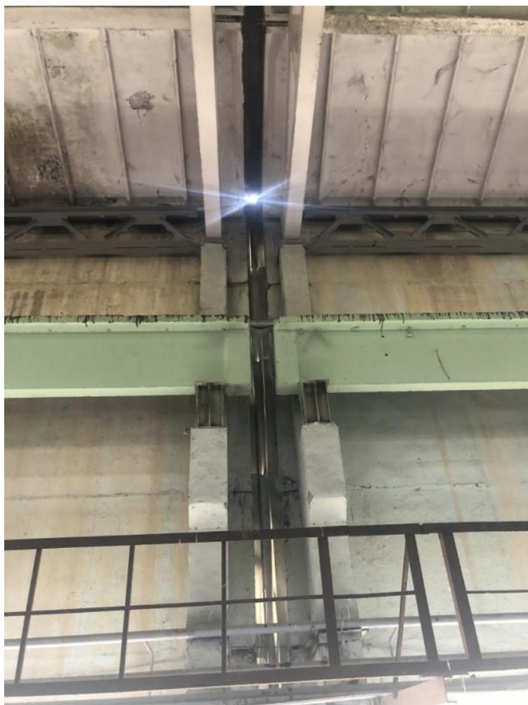
8.8-rasm. Toshkent lokomotiv deposti ta'mirlash sexi binosining bir bo'lagi (2019 yil); rasm sexni mukammal ta'mirlash oldidan olingan bo'lib, unda deformatsiya chokida o'rnatilgan qo'sh ustunlar, qo'sh to'sinlar, ko'prik kran osti to'sini, qovurg'ali yopma plitalar aks etgan
