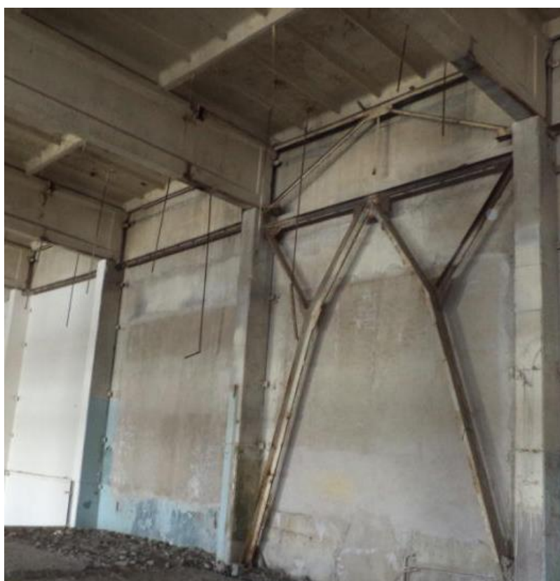
8.40-rasm. “Buxorotekstilsotton” qo‘shma korxonasi sanoat binosining o‘rta qismida ustunlar qatori bo‘ylab o‘rnatilgan poligonal metall bog‘lamaning, ustunlarning ustki qismi bo‘ylab o‘rnatilgan metall totqich-rasporkalarning va tom yopma to‘sinlari bikrligini ta‘minlash uchun o‘rnatilgan metall bog‘lamaning umumiy ko‘rinishi (2019 yil)
