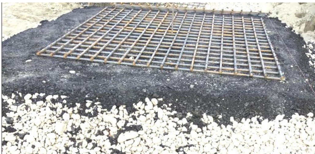
8.9-rasm. Poydevor asosida o'rnatilgan sun'iy shag'al qatlami, izolyasiya sifatida ishlatilgan asfalt va armatura to'ringining umumiy ko'rinishi
