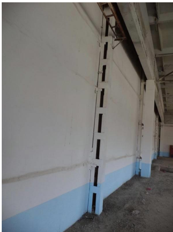
8.7-rasm. Buxorotekstilsotton qo'shma korxonasi binosining rekonstruksiya jarayonidagi ichki ko'rinishi bo'lagi (2019 yil); rasmda chetki asosiy ustun, faxverx ustunchalar, ularning devor panellari bilan tutashuvi va tom to'sinlari aks etgan
