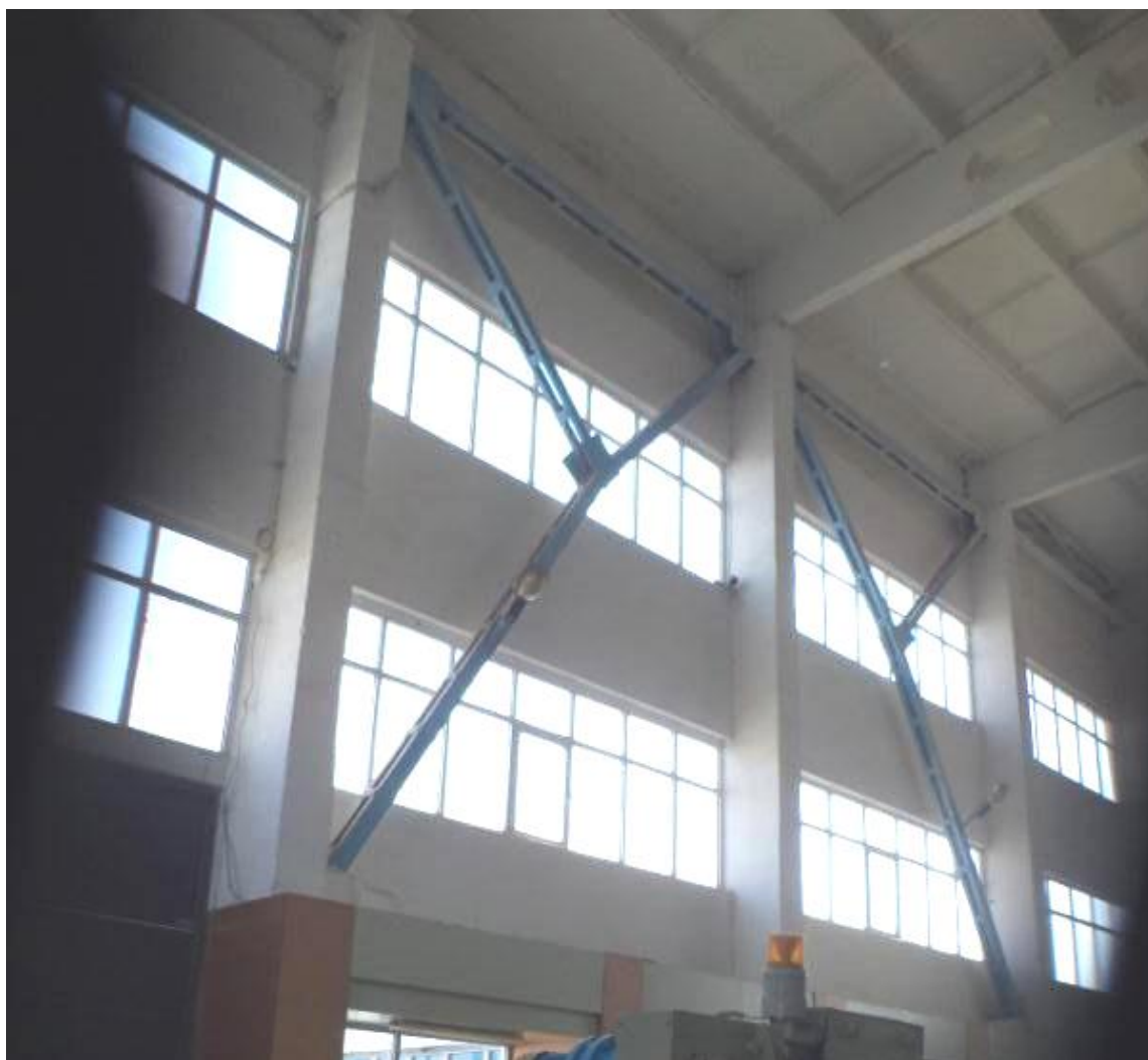
8.36-rasm. Sanoat binosining o'rta qismida ustunlar qatori bo'ylab o'rnatilgan poligonal metall bog'lamaning umumiy ko'rinishi
