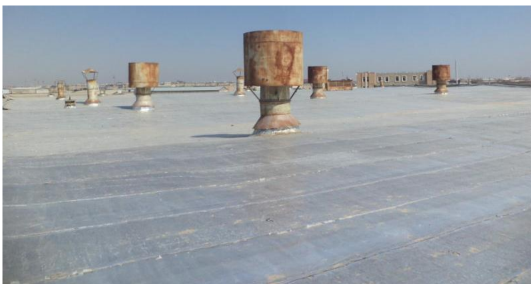
12.6-rasm. Folgaizoldan tayyorlangan tom krovlisining umumiy koʻrinishi
