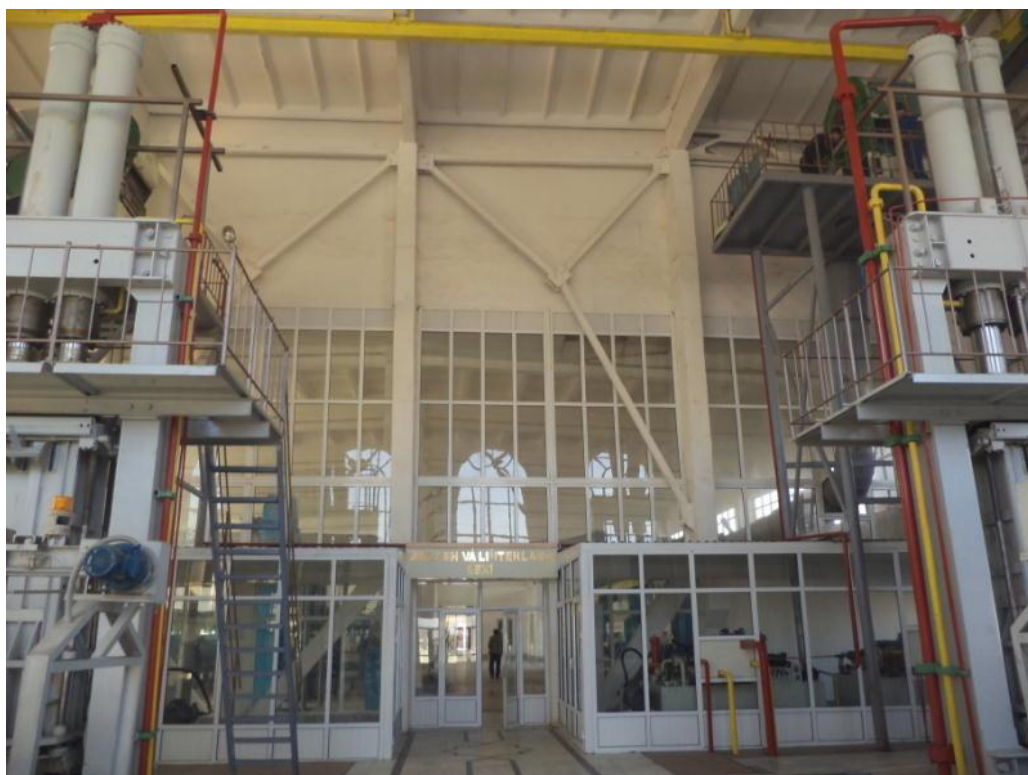
8.37-rasm. “Buxaratekstilsotton” qo‘shma korxonasi sanoat binosining 2-qavat o‘rta qismida ustunlar qatori bo‘ylab o‘rnatilgan poligonal metall bog‘lamaning umumiy ko‘rinishi (2019 yil)
