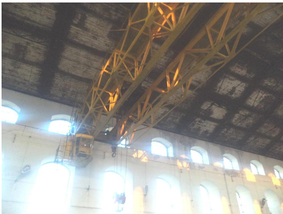
10.5-rasm. 1935 yilda qurib bitkazilgan tarixiy binoning ichki ko‘rinishi: devorlar g‘ishtdan qurilgan bo‘lib, uning ustida ko‘prik kran harakat qiladi; bino tomining ko‘taruvchi konstruksiyalari metall dan ishlangan
