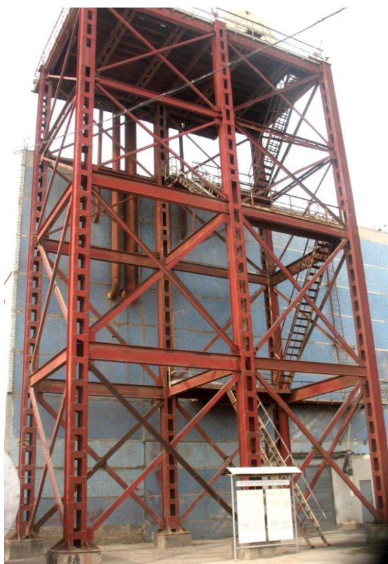
9.6-rasm. "Buxoroenegomarkaz" korxonasida metall konstruksiyalardan tiklangan inshootning umumiy ko'rinishi
