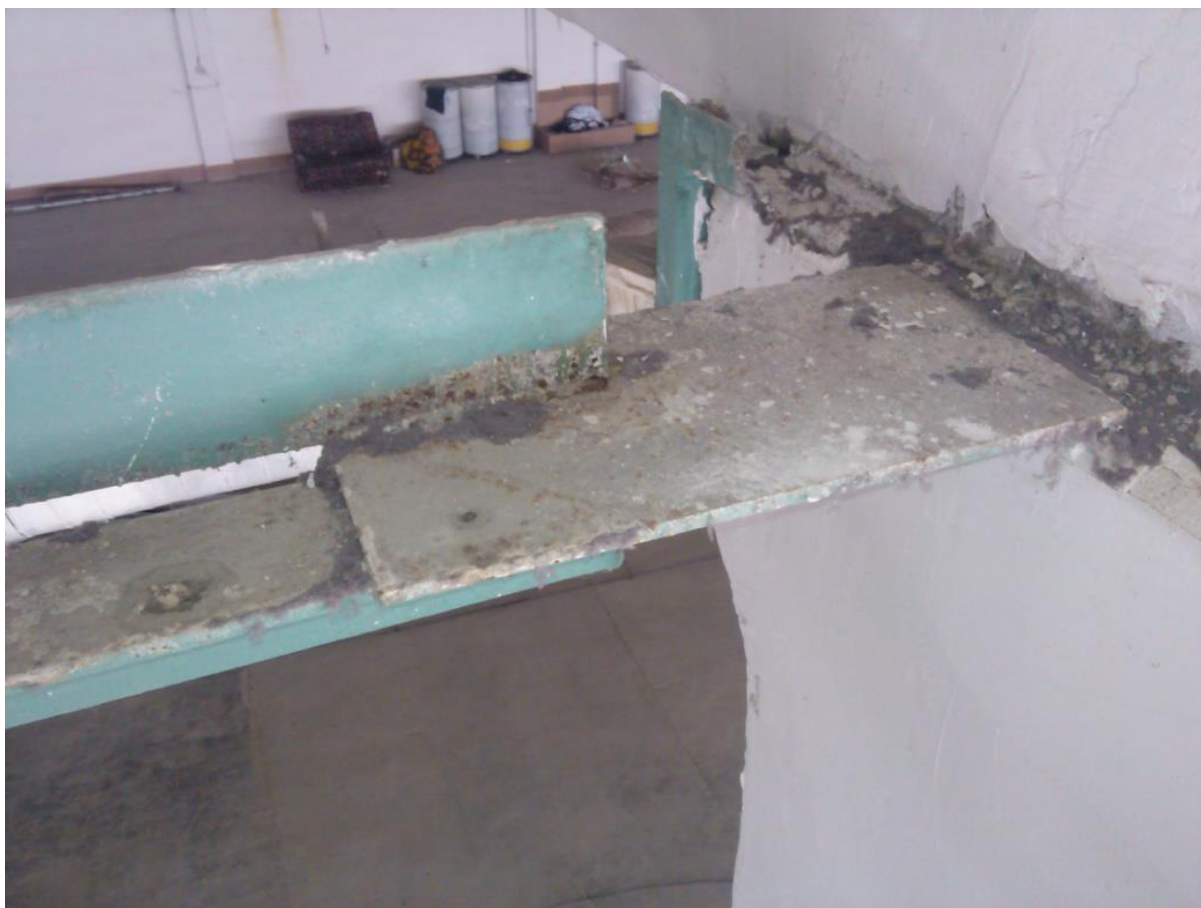
8.51-rasm. Ishlab chiqarish sexi bikrligini ta'minlash uchun ustunlar qadami bo'ylab ularning ustlarida o'rnatilgan metall rasporkaning ustunga mahkamlangan joyining umumiy ko'rinishi (2020 yil)
