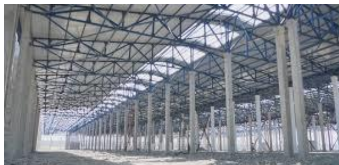
6.28-rasm. Qo'qon erkin iqtisodiy zonasida oddiy ustunlar to'ri bilan barpo etiladigan elektromobillar zavodi binosining qurilish jarayonidagi ichki ko'rinishi
