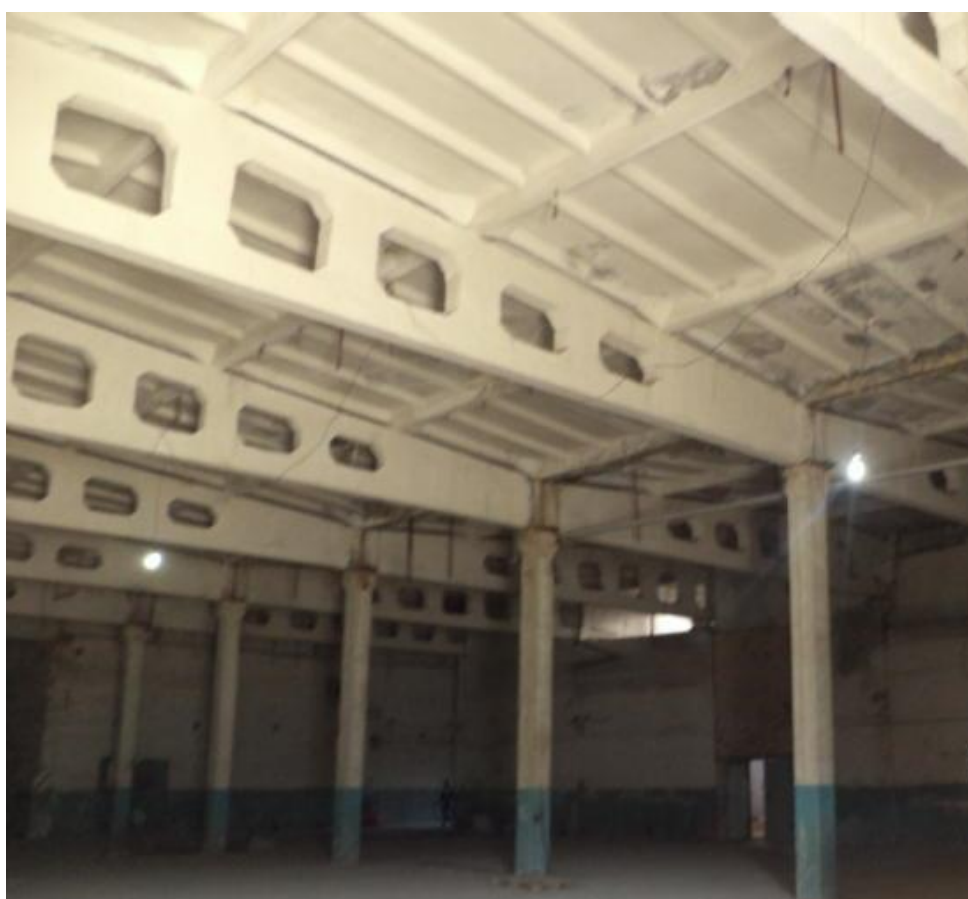
8.20-rasm. Buxoro shahridagi tekstil fabrikalardan birining ta'mirlashdan avvalgi ichki ko'rinishi; rasmda bir qavatli sanoat binosi temirbeton karkasining ustunlari, ikki nishabli kovakli to'sinlari va qovurg'ali tom yopma plitalari aks etgan (2019 yil)
