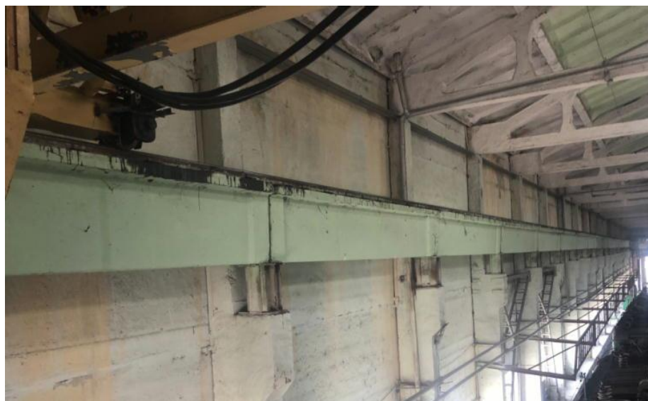
8.15-rasm. Toshkent lokomotiv deposti ta'mirlash sexi binosining bir bo'lagi (2019 yil); rasm sexni mukammal ta'mirlashdan avval olingan bo'lib, unda chetki qator ustunlari, ko'prik kran osti to'sinlari, fermalar, qovurg'ali tom yopmpa plitalari va devor panellari aks etgan
