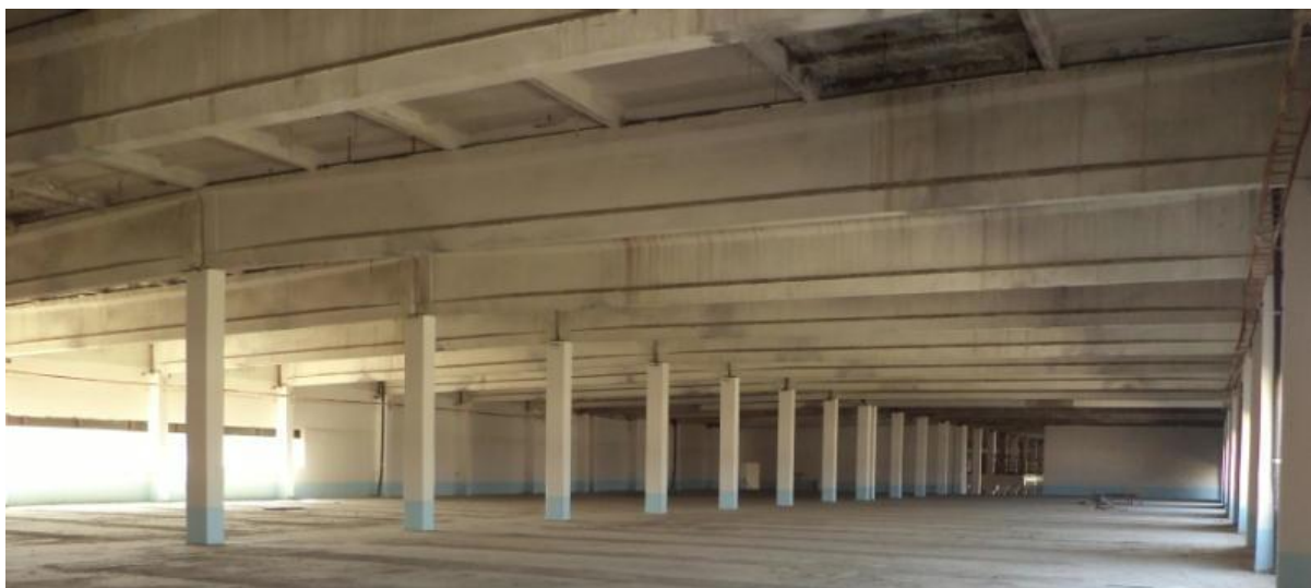
8.19-rasm. Buxorotekstilsotton qo'shma korxonasi sanoat binosi 2-qavatining mukammal ta'mirlashdan avvalgi ichki ko'rinishi (2019 yil); rasmda temirbeton ustunlar, to'sinlar, qovurg'ali tom yopma plitalari aks etgan
