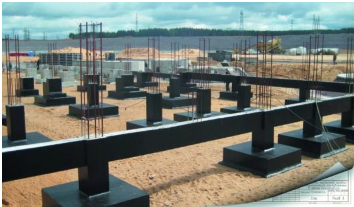
8.13-rasm. Sanoat binolarining ustunli temirbeton poydevorlari (ular ustiga devor o‘rnatish maqsadida temirbeton to‘sinlar bilan tutashtirilgan)
