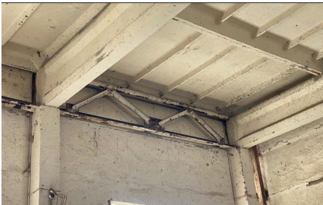
8.43-rasm. Ishlab chiqarish sexining bikrligini ta'minlash uchun chetka ustunlar qadami orasida to'sinlarga tik yo'nalidna o'rnatilgan ferma shaklidagi metall bog'lamaning umumiy ko'rinishi (2015 yil)
