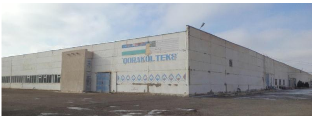
10.6-rasm. Devorlari yirik temirbeton panellardan tayyorlangan 1985 yilda qurilgan “Qorako‘l teks” korxonasi sanoat binosining umumiy ko‘rinishi
