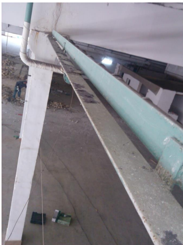
8.49-rasm. Omborxonaning bikrligini ta'minlash uchun ustunlar qadami bo'ylab ularning ustlarida o'rnatilgan metall rasporkalarning ustunlarga mahkamlangan joyining umumiy ko'rinishi (2019 yil)
