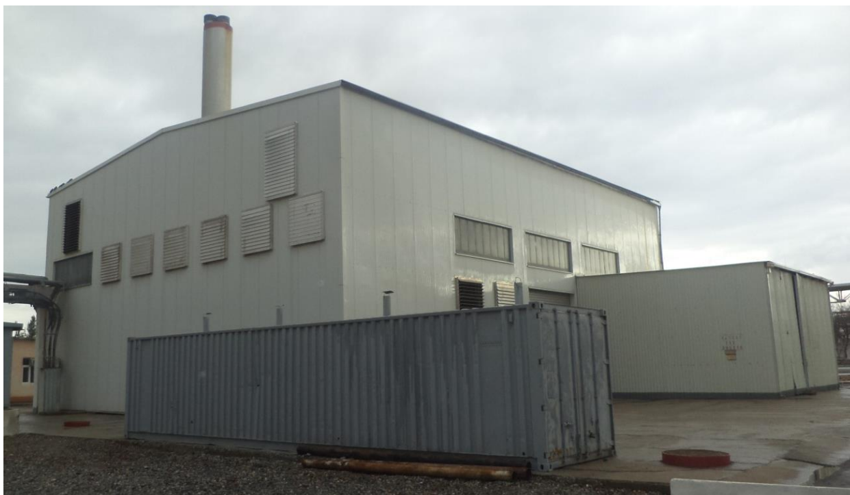
1.14-rasm. BNPZ ning issiqlik qozonxonasini umumiy ko‘rinishi
