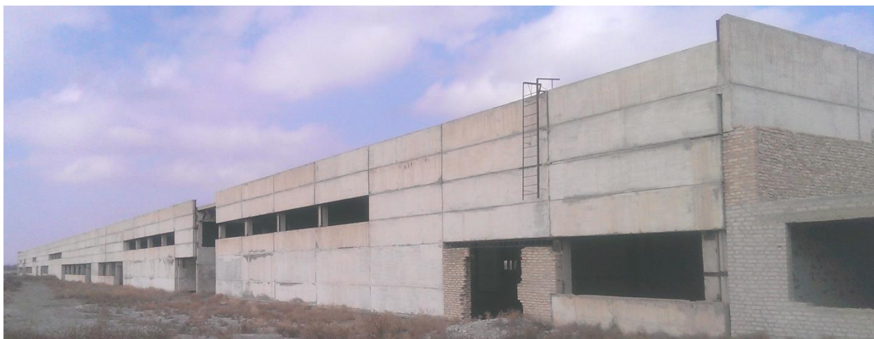
11.12-rasm. Romitan tumanining “Ustalar” qishlog‘ida 1985 yilda qurilishi boshlangan sanoat binosining tashqi devor panellari
