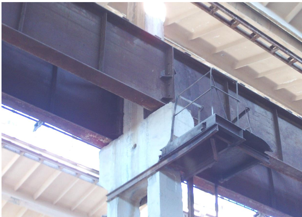
8.18-rasm. Buxoro uysozlik kombinati temir beton mahsulotlari ishlab chiqarish sexining bir tuguni (2020 yil); rasm sexni buzilishidan avval olingan bo‘lib, unda metallardan tayyorlangan ko‘prik kran osti to‘sininig ustun rafaqiga tayantirib mahkamlangan joyi aks etgan
