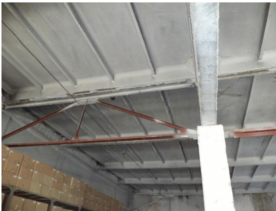
8.45-rasm. Omborxonaning bikrligini ta'minlash uchun chetka ustunlar qadami orasida to'sinlarga tik yo'nalidna o'rnatilgan ferma shaklidagi metall bog'lamaning umumiy va keyingi ustunlar qadami orasida o'rnatilgan tortqich-rasporka bir bo'lagining ko'rinishi (2019 yil)
