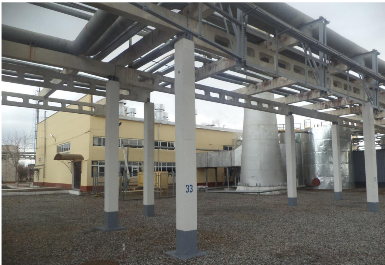
1.15-rasm. BNPZ kompressor stansiyasi binosining umumiy ko‘rinishi
