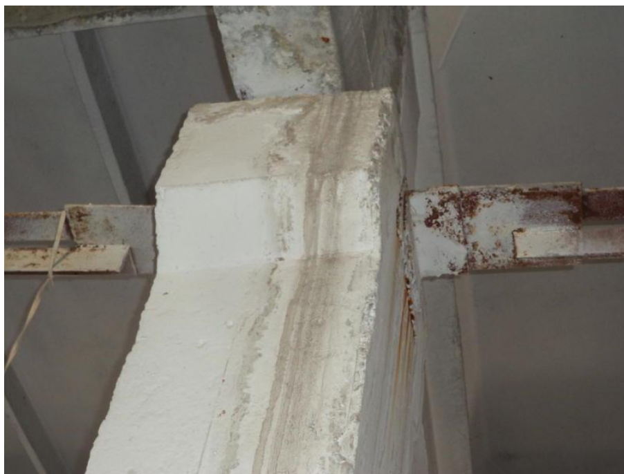
8.49-rasm. Omborxonaning bikrligini ta'minlash uchun ustunlar qadami bo'ylab ularning ustlarida o'rnatilgan metall rasporkalarning ustunlarga mahkamlangan joyining umumiy ko'rinishi (2019 yil)
