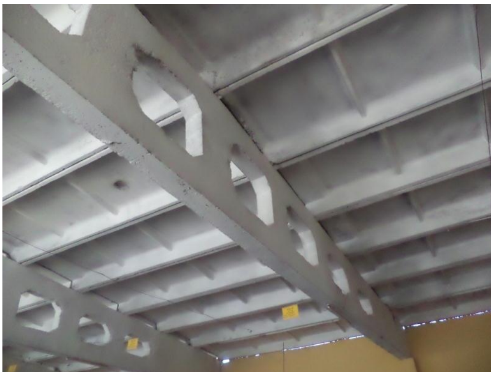
8.21-rasm. Buxoro shahridagi sanoat binolaridan birining bir bo‘lagi; rasmda bir qavatli sanoat binosi temirbeton karkasining ikki nishabli kovakli to‘sinlari va qovurg‘ali tom yopma plitalari aks etgan (2020 yil)
