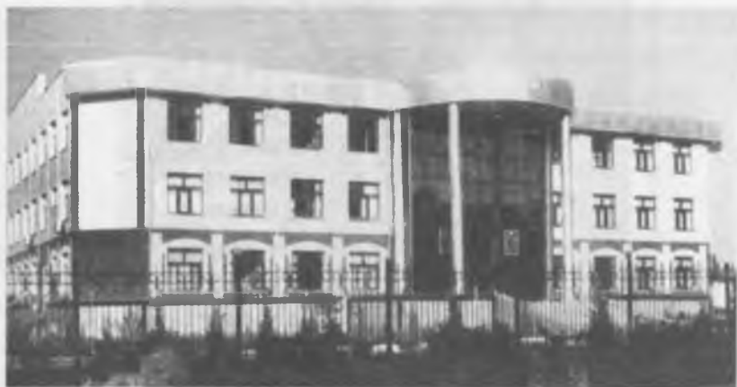
13.86-rasm. Jizzax shahridagi Soliq inspeksiyasi binosi
