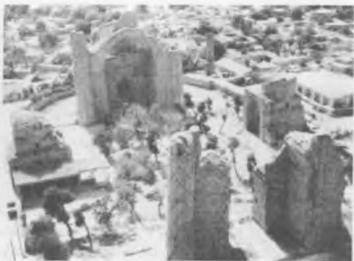
9.7-rasm. Bibixonim masjidining restavratsiyadan avvalgi holati (1399 – 1404-yillarda qurilgan)
