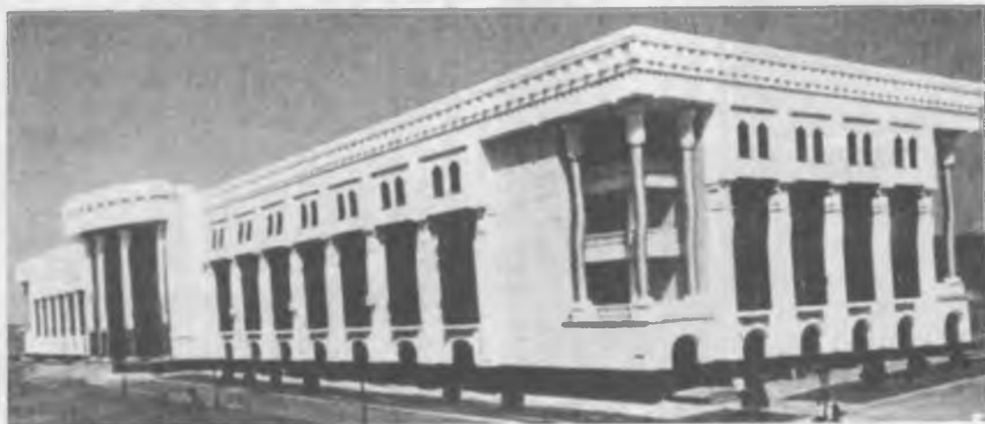
13.55-rasm. Toshkent davlat konservatoriyasining yangi binosi
