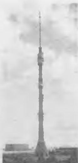
7.3 - rasm. Moskvadagi Ostankino teleminorasi (1960–1968-yillarda qurilgan, balandligi 540 m, 370 m balandlikda uchta restoran joylashgan)
