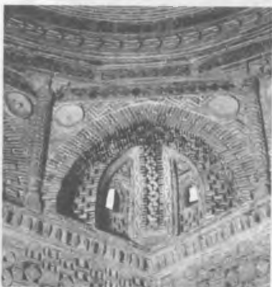
10.13-rasm. Ismoil Somoniy maqbarasining to'rt devordan gumbuzga o'tishdagi sakkiz arkali g'ishili bezakdor konstruksiyasi (1—devor bo'ylab o'rnatilgan arka; 2—burchakda ishlangan arka)
