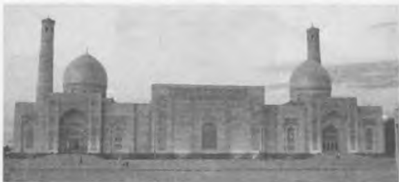
13. 18-rasm. Milliy uslubda qurilgan Hazrati Imom masjidining orqa tomondan ko'rinishi (xonani yoritish uchun fonarlari bo'lgan baraban shaklidagi gumbaz o'rnatilgan
