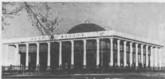
13.41-rasm. To'rttala fasadi ham bir xil bo'lgan Oliy Majlis binosining umumiy ko'rinishi
