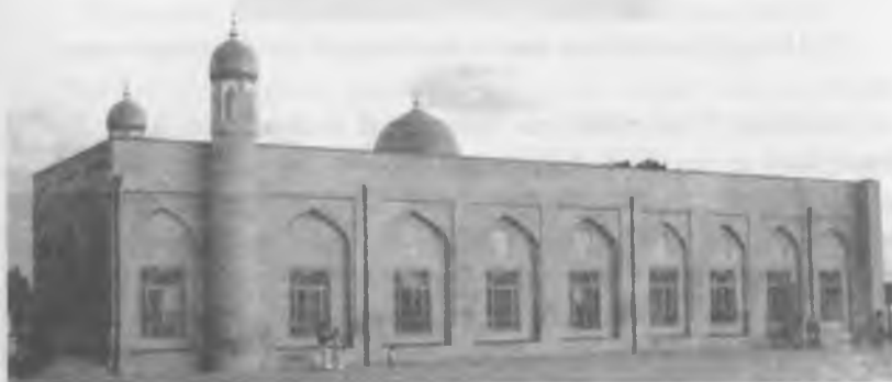
13.21-rasm. Hazratl Imom masjidi kompleksidagi milliy uslubda ishlangan zamonaviy binoning umumiy ko'rinishi
