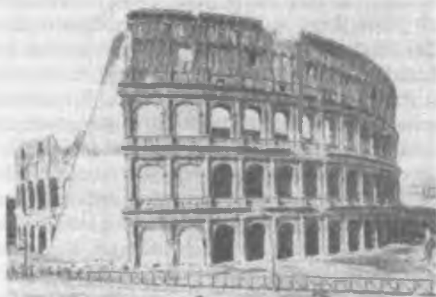
1.1.1-rasm. Kolizey. Ta'mirlash jarayonida o'rnatilgan dastlabki tirkak devor. Yodgorlik tarzi inobatga olinmagan (15-ad., 11-b.)
