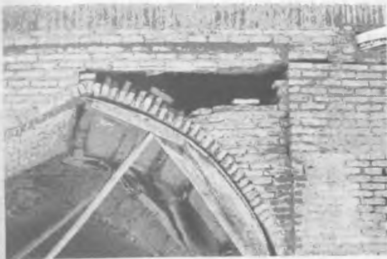
3.1.2-rasm. Ravoqni linga yordamida tiklash va ravoq oralig'ida havo yurish kanali – "xataba"ning qo'llanilishi.
