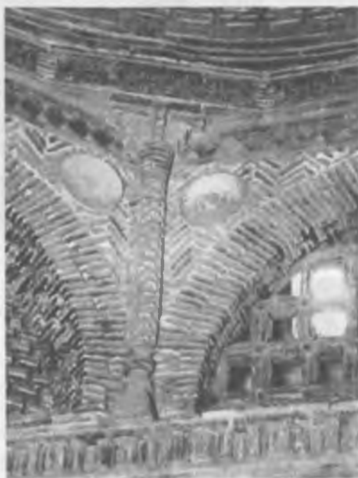
10.14-rasm. Ismoil Somonty maqbarasining arkalar oralig'idagi bezakdor g'ishtli konstruksiyasi (sakkiz arkali konstruksiyasining elementlari)
