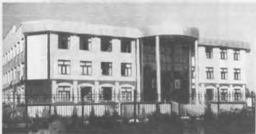
13.86-rasm. Jizzax shahridagi Soliq inspeksiyasi binosi
