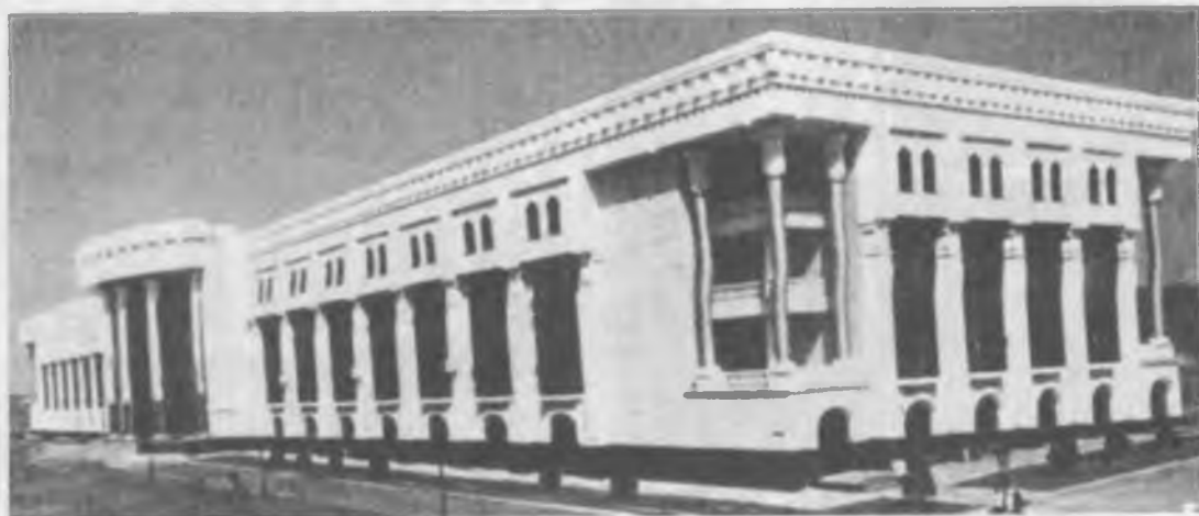
13.55-rasm. Toshkent davlat konservatoriyasining yangi binosi
