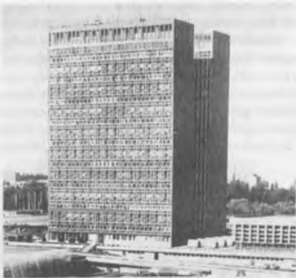
12.15-rasm. Toshkent shahridagi birinchi eng baland bino – avvalgi 19 qavatli ma'muriy binoning umumiy ko'rinishi (1972-yil)
