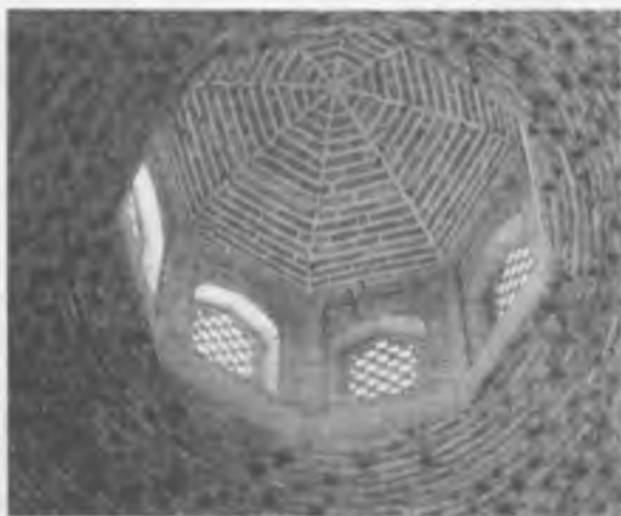
10.46 - rasm. «Toqi Sarrafon» barabanli gumbazining naqshinkor to'rli proyomlari bilan ostidan ko'rinishi
