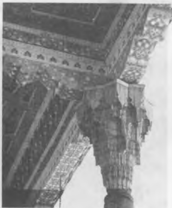
14. 17-rasm. Mustaqillik davrida (2003) Bahouddin Naqshbandiy me'moriy kompleksi yangi qurilgan ayvoni ustunining pastki qismiga qo'llanilgan bezakli marmartosh va uning ustki naqshinkor kallagi
