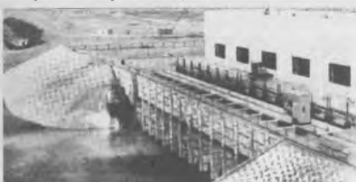
13.1-rasm. Arnasoy suv ombori 1- nasos stansiyasining umumiy ko'rinishi
