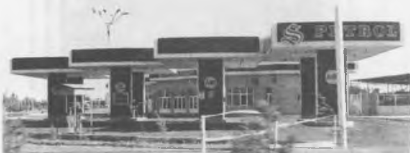
13.96-rasm. Zamonaviy uslubda ishlangan Buxoro shahridagi avtomobil yonilg'isi quyish shaxobchasining umumiy ko'rinishi
