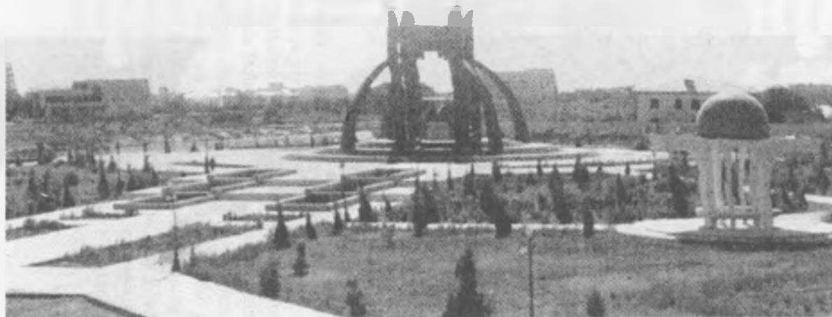
13.81-rasm. Urganch shahri. Avesto bog'ining umumiy ko'rinishi
