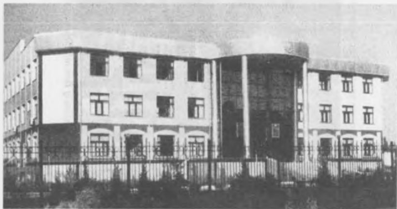
13.86-rasm Jizzax shahridagi Soliq inspeksiyasi binosi
