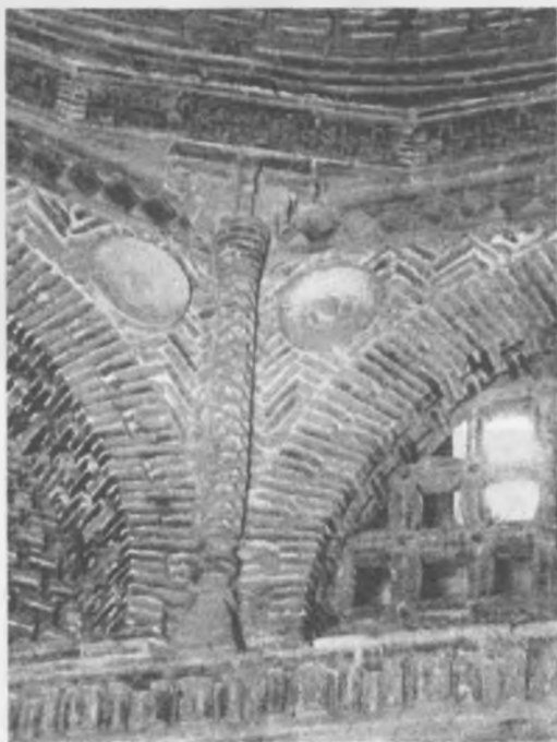
10.14-rasm. Ismoil Somoniy maqbarasining arkalar oralig'idagi bezakdor g'ishli konstruksiyasi (sakkiz arkali konstruksiyasining elementlari)
