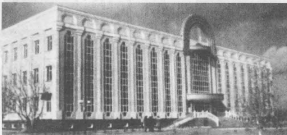
13.62- rasm. Qoraqalpog'iston. Bo'ston shahridagi musiqa kolleji binosining umumiy ko'rinishi
