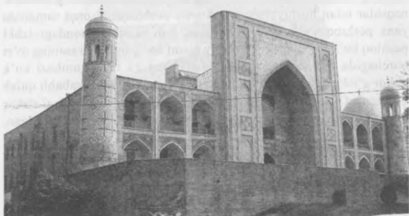
12.5-rasm Toshkentdagi Ko'kaldosh madrasasining umumiy ko'rinishi (XVI asr)
