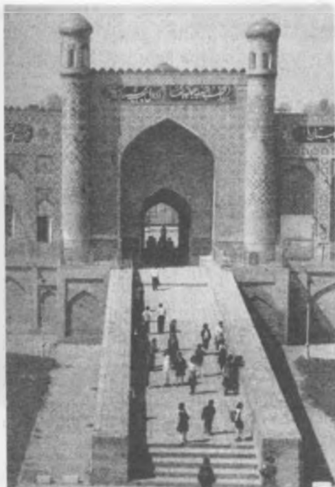
13.34-rasm. Qo'qondagi restavratsiya qilingan Xudoyorxon o'rdasi
