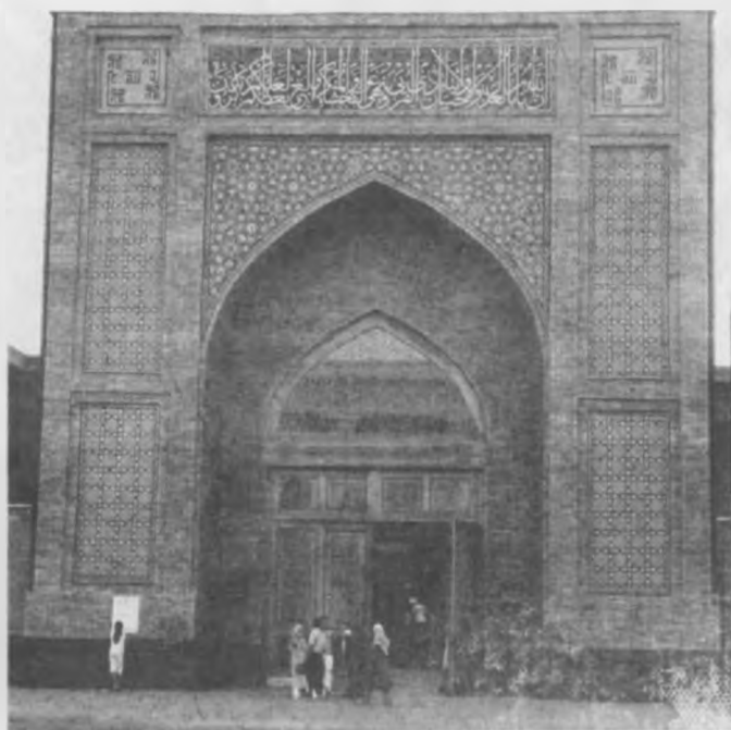
13.17-rasm Milliy uslubda qurilgan Hazrati Imom masjidining naqshli darvozasining ko'rinishi
