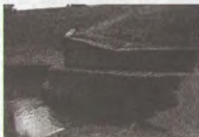
101-rasm. Suv atrofini tirgak devorlar bilan terraslash.
