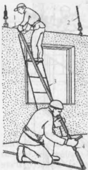
56-пачм Devor panelini o'rnatish: 1—strubsina; 2—strop; 3—tirgak; 4—tortish muftasi.
