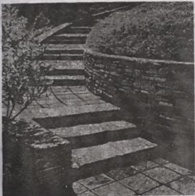
Рис. 16. Лестница и подпорная стенка.
