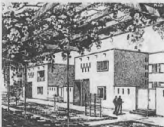
Toshkent. S-5 kvartalidagi blokli turar uylarning qurilishi.
