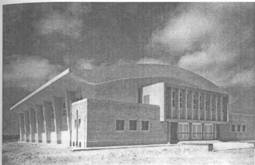
Спортивное сооружение комплекса
