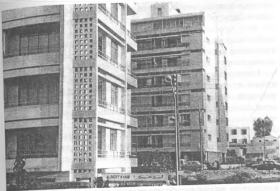
Ливан. 8-этажный жилой дом в Бейруте
