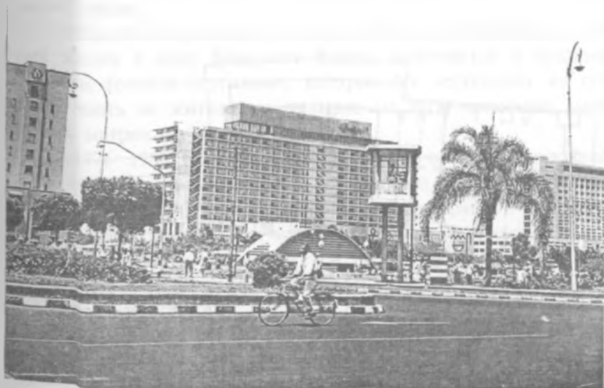
Каир. Гостиница «Хилтон» на набережной Нила. Арх. В. Беккет, М. Рияд
