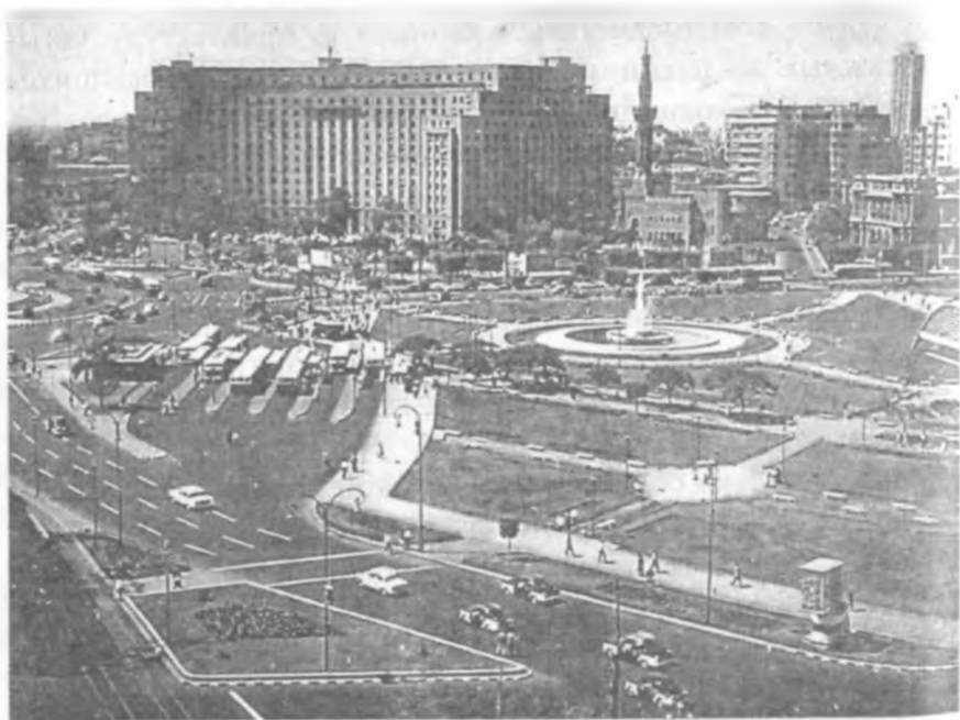
Площадь Ат-Тахрир до реконструкции
