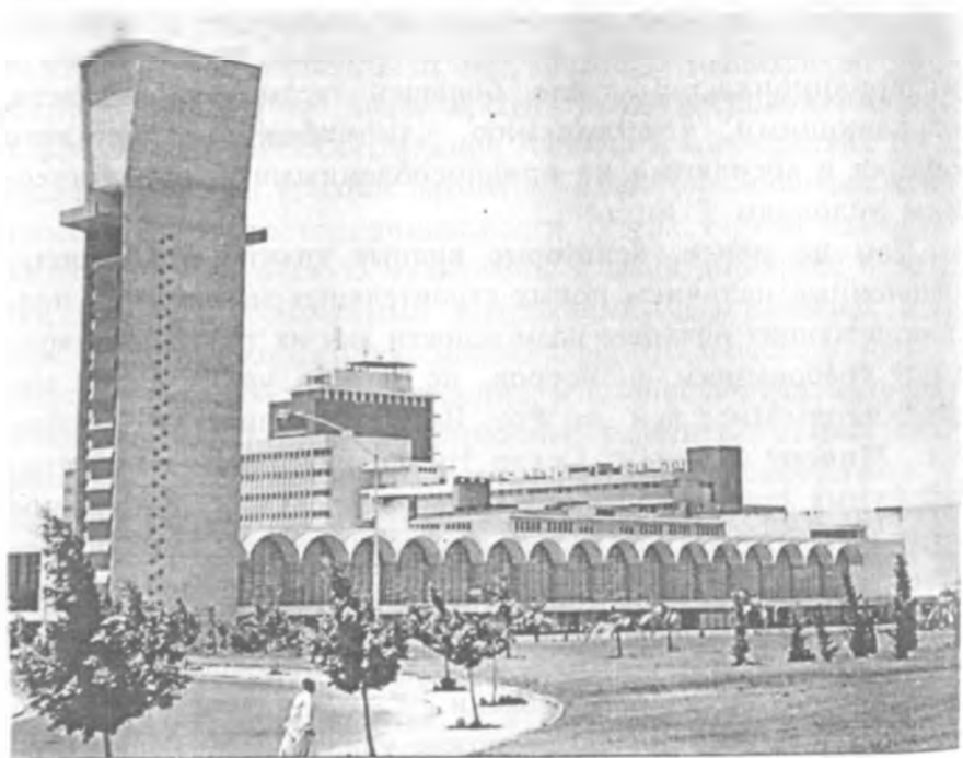
Боковой фасад аэропорта
