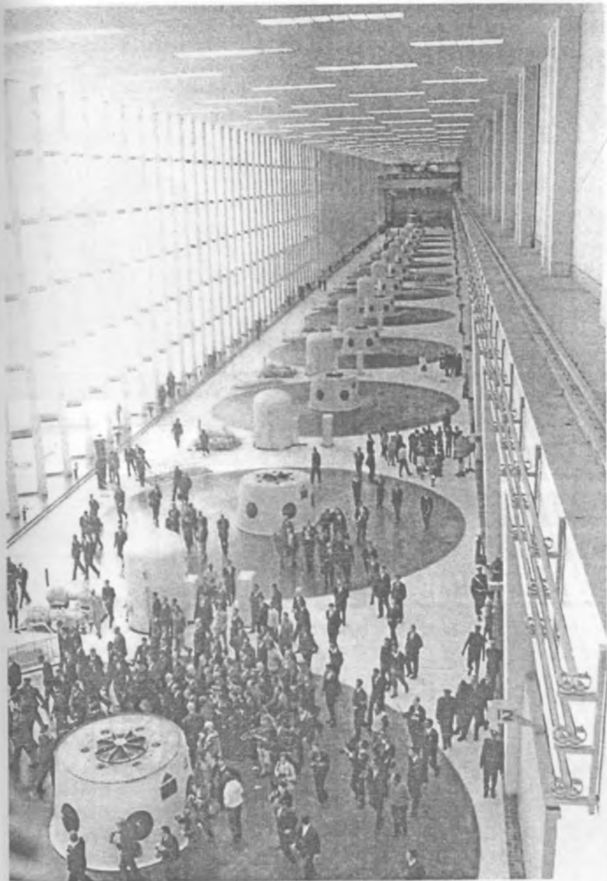
Турбинный зал плотины
