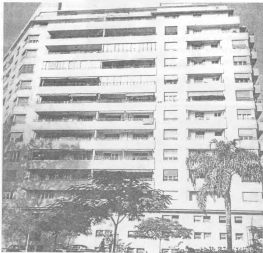
Каир, Замалек. 12-этажный жилой дом. 1952 г. Архитектор Харстян Пальян
