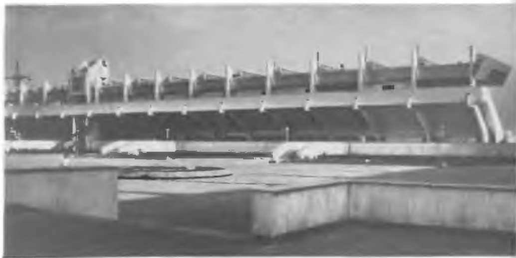
Рис. 19.14. Трибуны конно-спортивного комплекса в Битце. Москва. Архитекторы М. Шипилов, Кезлер
