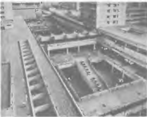
Рис. 24.4. Торговый центр в Нордвеститадте, ФРГ. Общий вид, фрагмент
