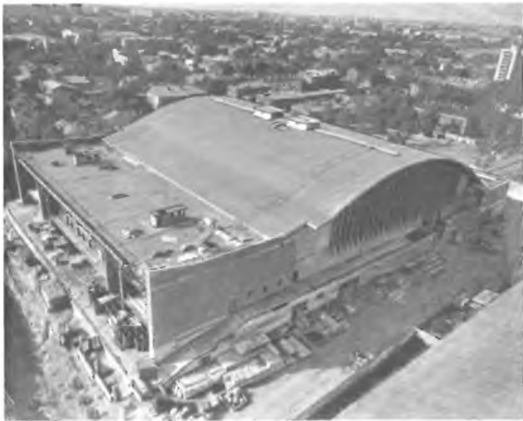
Рис. 4.13. Крытый каток Перевосклеенные конструкции
