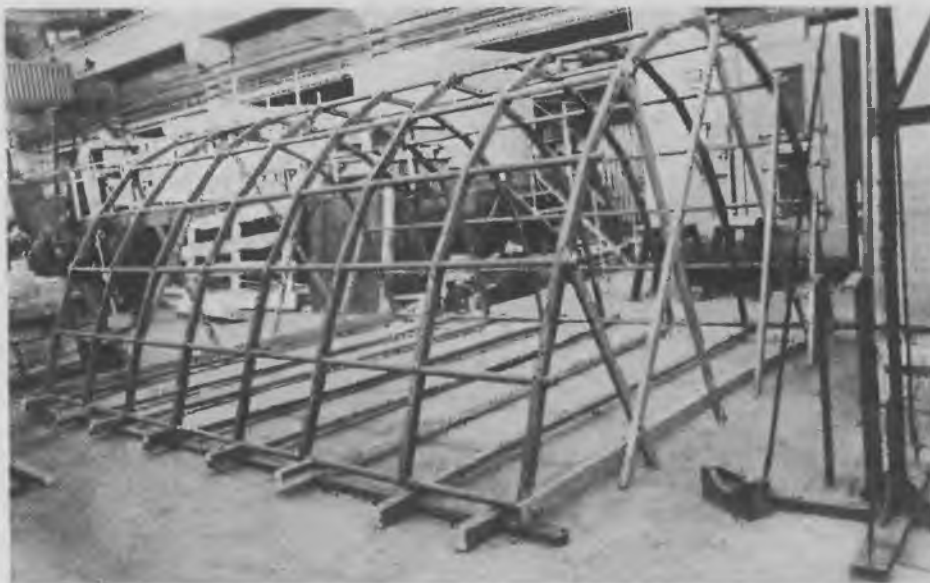
Рис. 71. Общий вид каркаса упругогибкого покрытия. Авторы конструкции: инженеры В.Г. Темнов, Е.Н. Митрофанов, архит. Ю.С. Лебедев
