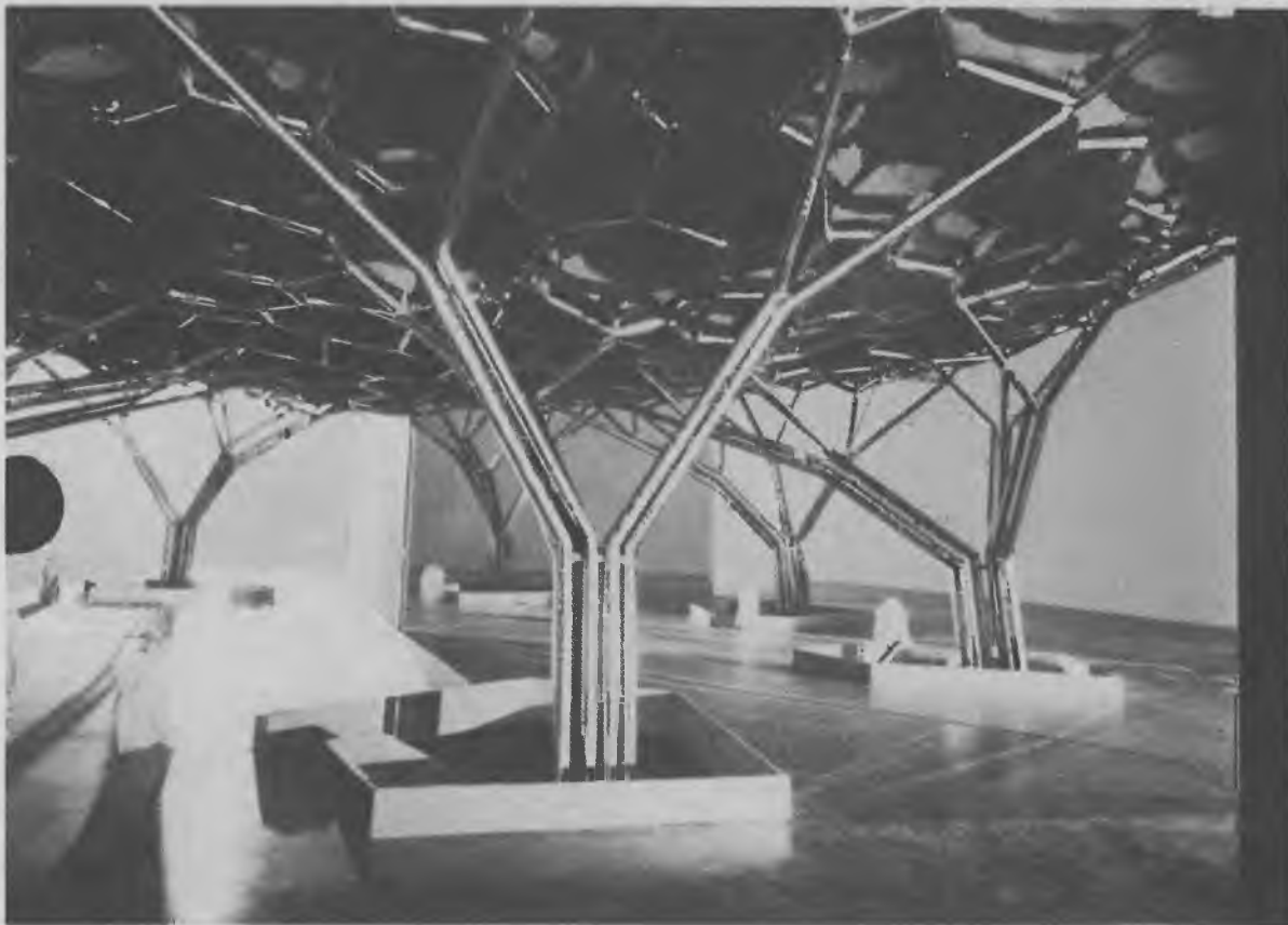
Рис. 11. Ветвящиеся опоры по аналогии со стволом дерева. Проект здания для Саудовской Аравии. Архит.: бюро Гутброта, Зап. Берлин — Штутгарт; Инж.: бюро Э. Хаппольд, Бат (Англия); Под рук. ИЛ, Ф. Отто, Штутгарт — Вармброн
