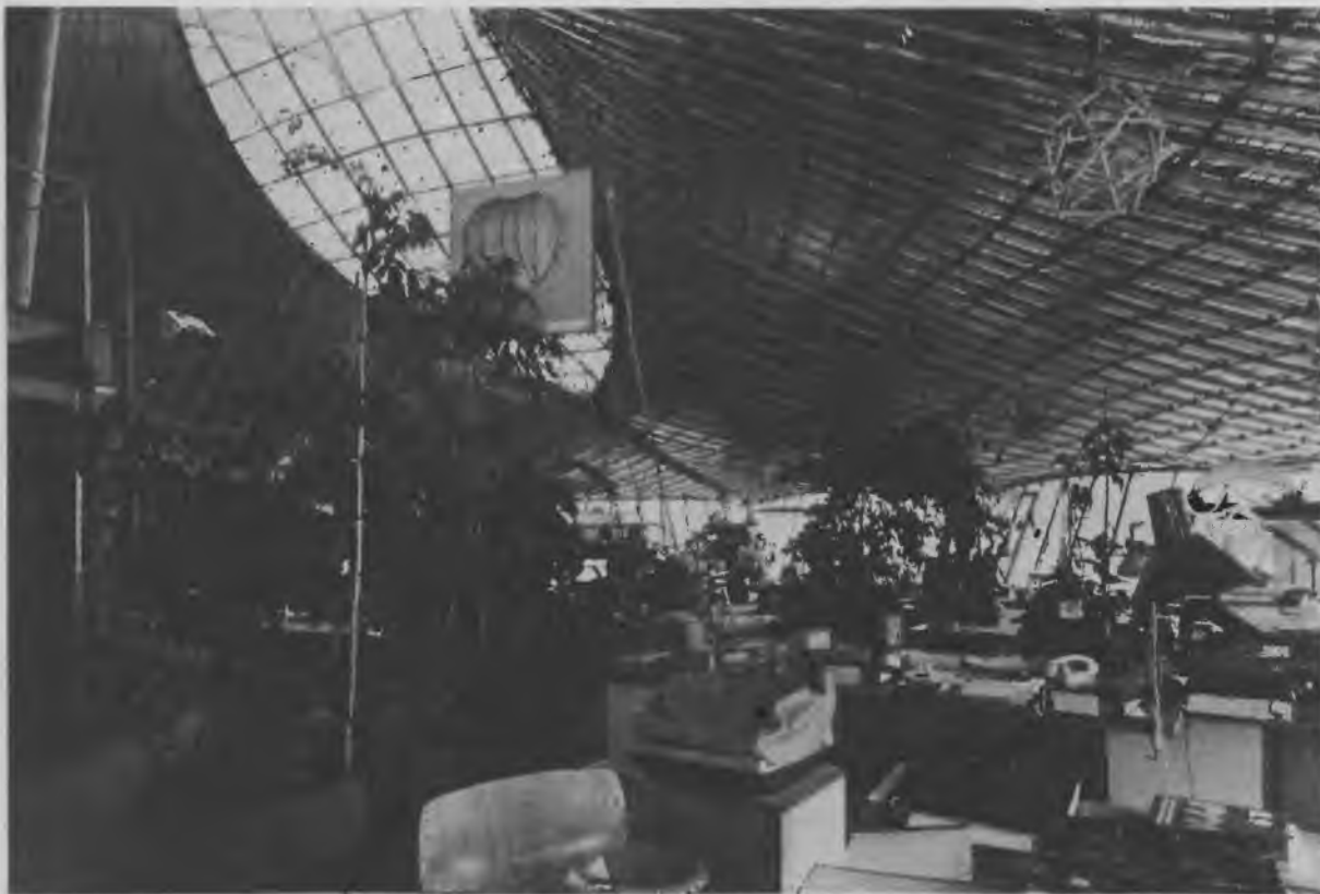
Рис. 1. Интерьер Института легких конструкций Штутгартского университета. Сетчатое покрытие здания с капитальной кровлей
