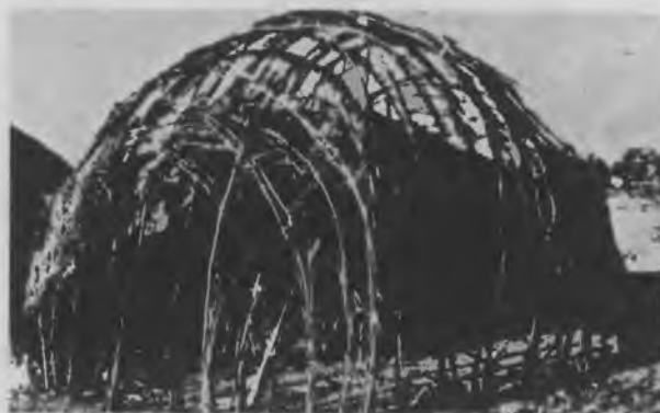
Рис. 19. Переносное жилище из местных строительных материалов кочевников Сомели (Африка). Общий конструктивный вид жилища и его план
