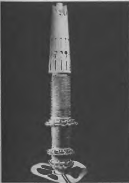
Рис. 44. Модель сверхвысотного сооружения с демпфирующими устройствами. Общий вид и фрагмент. Архит. А.И. Лазарев
