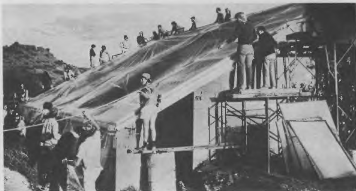
Рис. 70. Аркозанти. Строительный процесс
