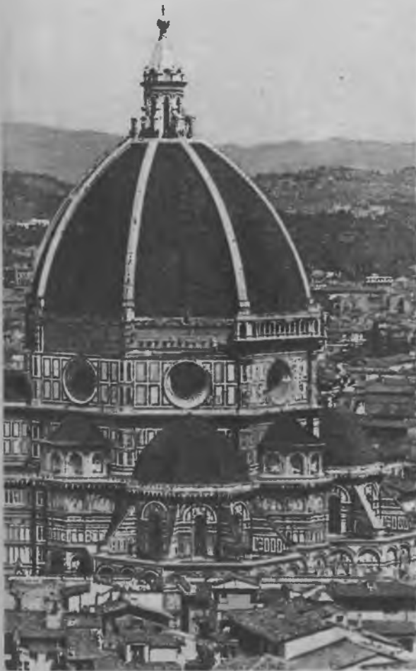
Рис. 1. Скорлупа яйца — использование конструкции и формы. Скорлупа яйца и купол Флорентийского собора Санта Мария дель Фьоре, 1420—1434 гг. Архит. Брунеллеско
