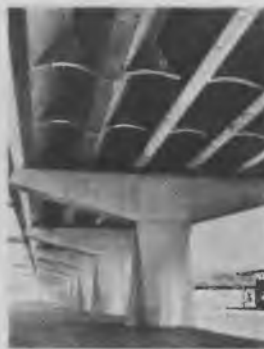
Рис. 40. Интерьер главного зала Туринской выставки, Италия, 1948 г. Пролет 98 м. Инж. П.Л. Нерви. Природный аналог — лист экзотического цветка Виктории регии (микроструктура)
