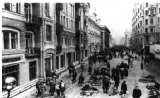
Новые здания в брандмауэрной застройке улицы (Самара)
