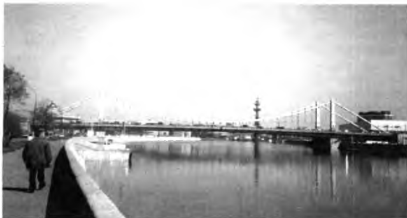
Крымский мост в Москве
