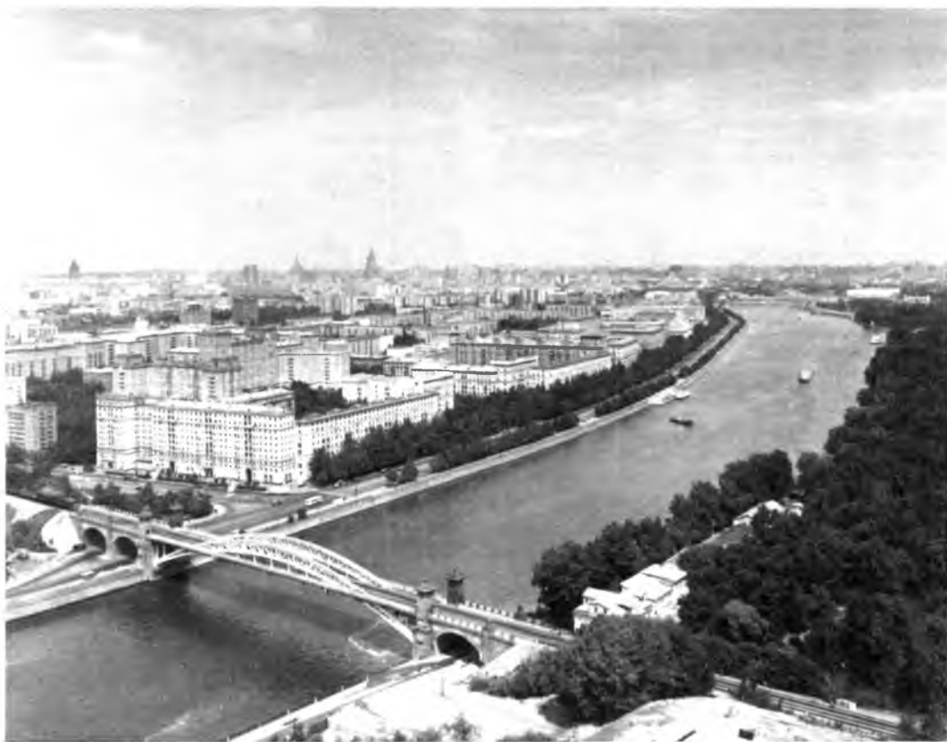
Арочный мост. Главный пролет — металлический (в центре), боковые пролеты — железобетонные
