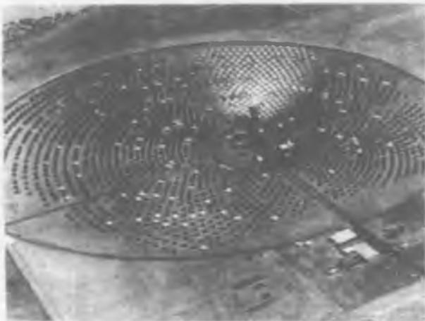
Эта экспериментальная электрическая станция в Бристоу (Калифорния) работает от солнечных лучей. На фото: 1919 гелиостатов, или зеркал, которые отражают солнечные лучи на башню. Станция закрылась в 1987 г. после падения цен на нефть. Как спрос и предложение повлияли на развитие энергетики?
