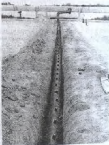
24-rasm. Temir-beton novdan suv olinib, suv egatlarga tuproq ostidan taqsimlanadigan tizimning ko'rinishi.
