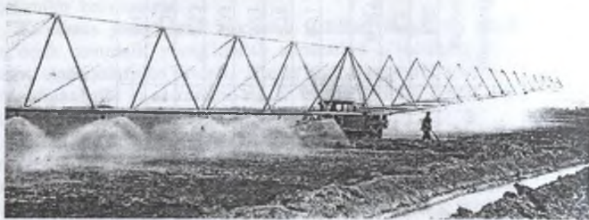
30-rasm. ДДА-100МА yomg'irlatib sug'orish агрегати.
