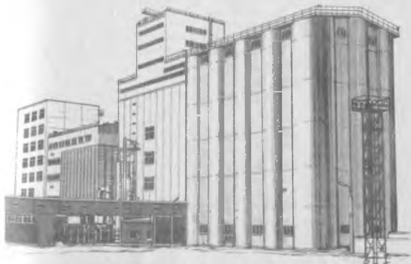
Рис. 11. Металлический силосный корпус с силосами диаметром 7,8 м конструкции ЧССР, возведенный в г. Владимире
