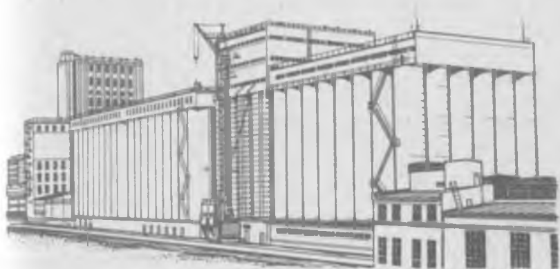
Рис. 7. Сборный силосный корпус СКС-6-48 конструкции ЦНИИпромзернопроект с силосами диаметром 6 м, построенный в Москве на мелькомбинате № 4 (первый справа)
