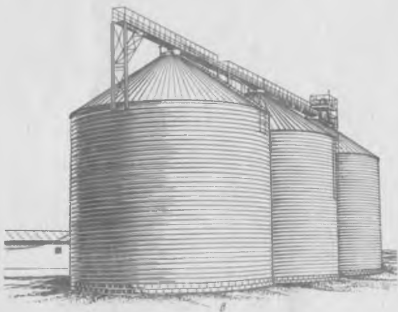
Рис. 10. Металлические силосы, возводимые методом наливки:
