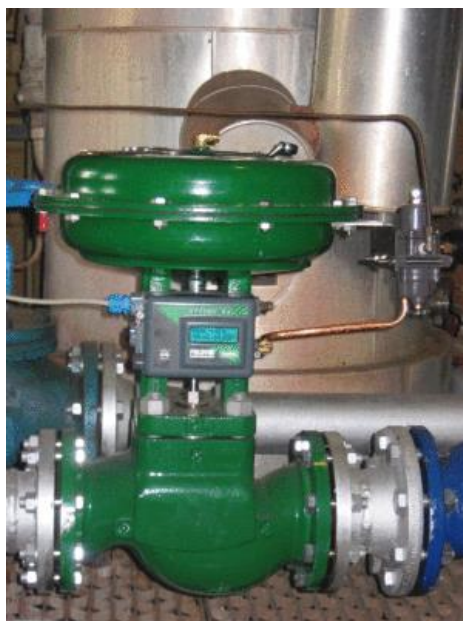
9.29-rasm. Rostlanadigan klapandagi membranali pnevmatik yuritma
