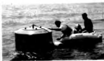
79-rasm. Porshenli po'kaklarni o'rnatish jarayoni (a va b) va undan chiqayotgan suv (d).
