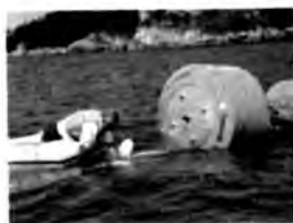
79-rasm. Porshenli po'kaklarni o'rnatish jarayoni (a va b) va undan chiqayotgan suv (d).
